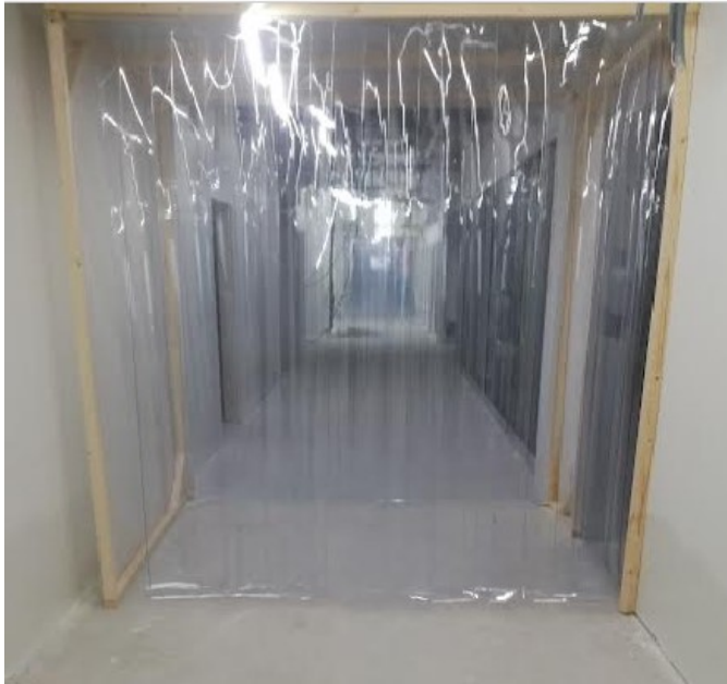
Kuva 8 Lohkojen rajalla oleva kulkuaukko
