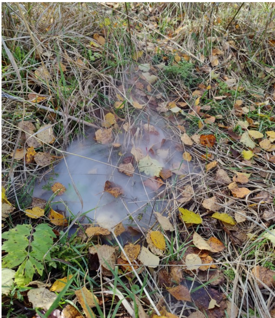
Kuva 24. Savu kulkeutuu maaperän läpi vuotavasta betoniviemäristä (Rantavuo 2021)
