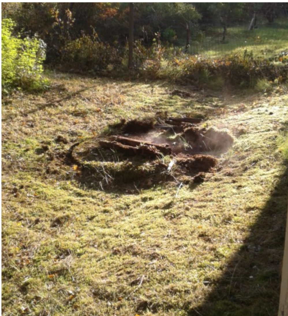
Kuva 22. Maasto viettää kohti betonista viemärikaivoa mahdollistaen huleveden päätyminen jätevesiviemäriin (Rantavuo 2021)
