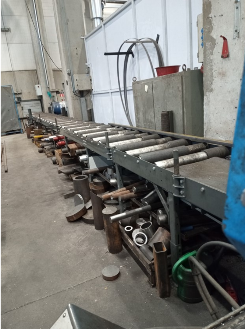
Kuva 2. Syöttöpuolella oleva vapaarata (Ketola 2021).
