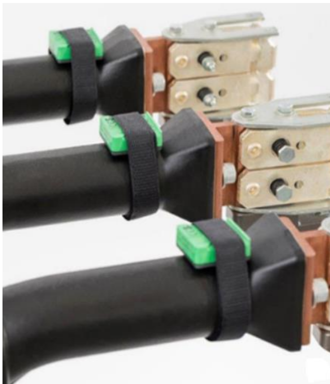
KUVA 20. Kiristysnauhalla liittimiin asennetut langattomat lämpösensorit (23).
