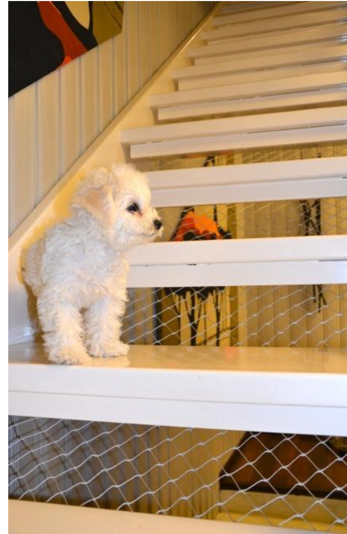
Kuva 33: Kuvassa avoportaat, jotka jouduttu muokkaamaan koiraturvalliseksi asentamalla kalaverkko portaikon alaosaan, jottei pieni koira pääse tippumaan portaikosta ja satuttamaan itseään.
