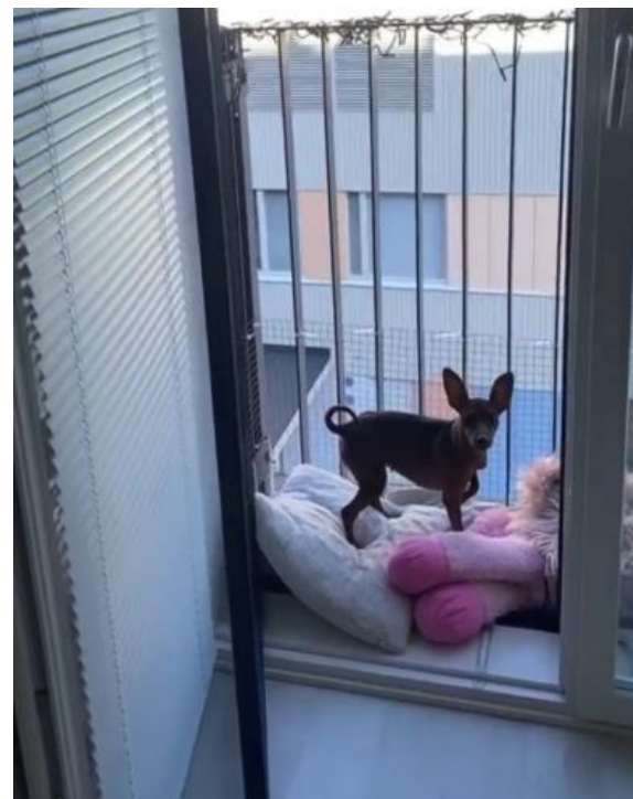
Kuva 32: Pieni koira voi mahtua putoamaan kaiteen pinnojen välistä. Tässä kuvassa koiranomistaja on asentanut kaiteen alareunaan verkon koiran putoamisen estämiseksi.
