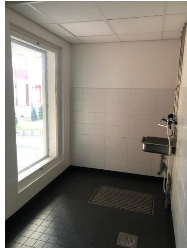
Kuva 39: Järvenpään Garden. 2021. Arkkitehti Mirva Mehtonen. Kuvassa B-rakennuksen kuraeteinen. Kuraeteinen on syvennyksessä heti sisäänkäynnin välittömässä läheisyydessä. Kurapisteelle on näköyhteys ulkoa ulko-oven edestä ikkunan läpi. Kuva Vilinä Eskelinen. 2021.
