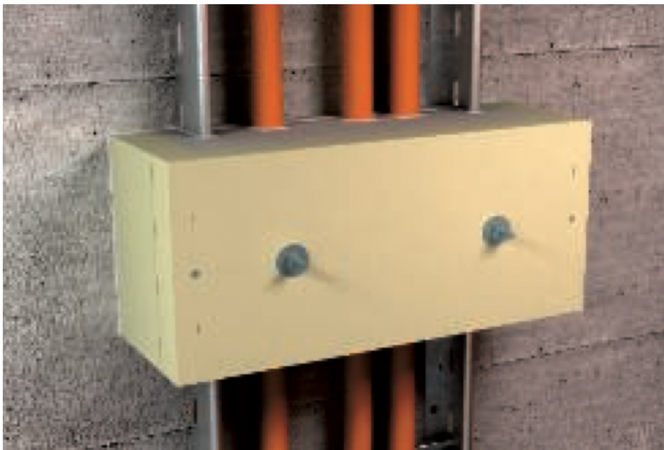
Kuva 14: palonkestoisten kaapeleiden vedonpoisto. [16]
