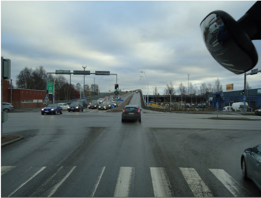
KUVA 6. Limingantien ja Joutsensillan liittymä kuvattuna joutsensiltaa vastapäätä (17)
