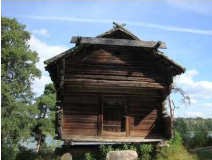
Kuva 9. Vaakasuuntainen solkilankku pitää painopuita paikallaan.
