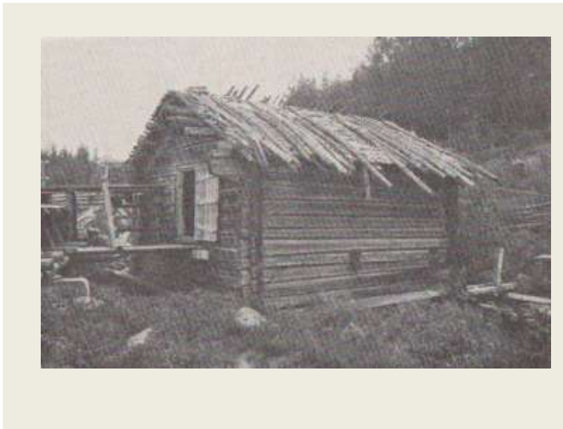
Kuva 3. Epämääräinen malkakatto jalkamylyssä Konginkankaalla (Hämäläinen 1930, 224).
