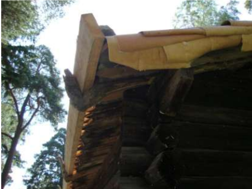
Kuva 6. Räystäslauta on räystäskoukkujen varassa.
