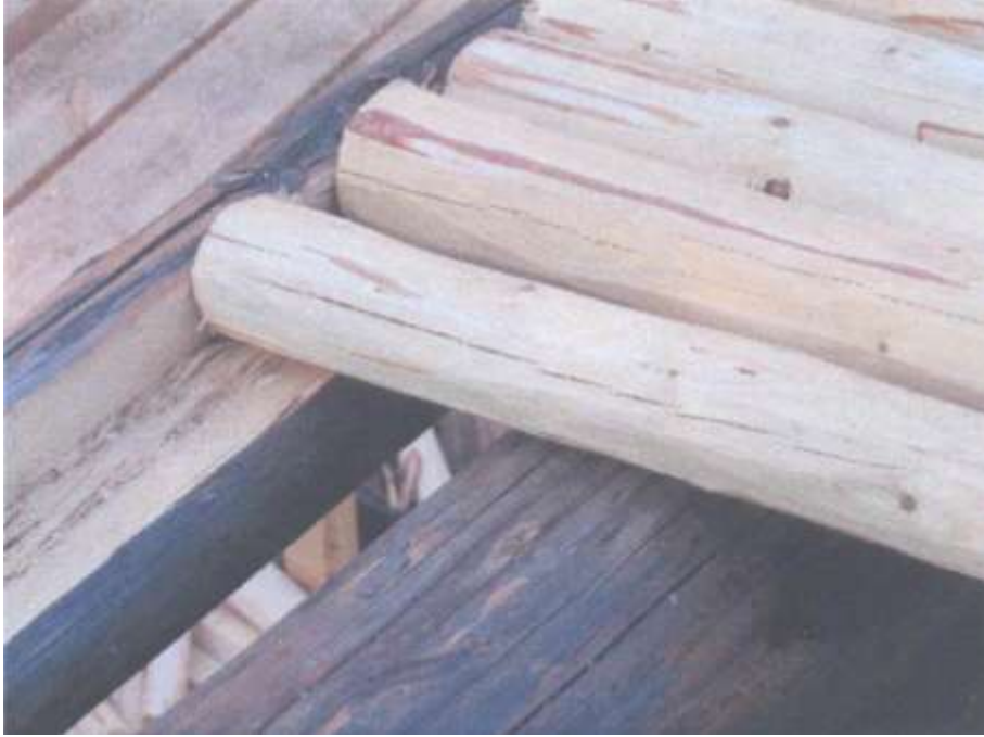
Kuva 7. Alusmalat asettuvat siihirteen veistettyyn hahloon (Harmaala 2007, 65).
