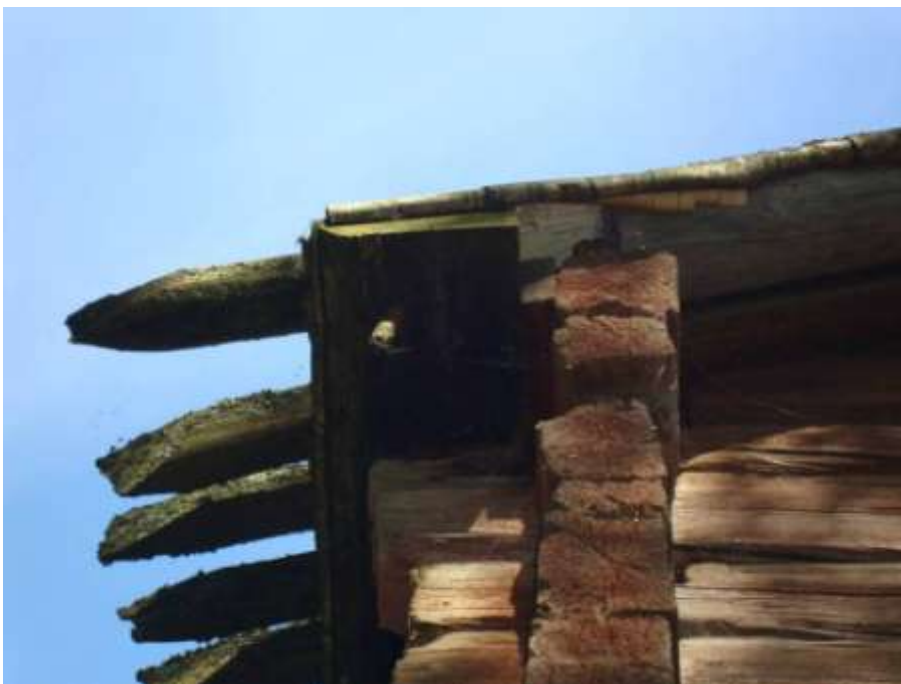
Kuva 16. Luhdin malkakaton reunimmaisiet malat on tapitettu kiinni rästäspuuhun.
