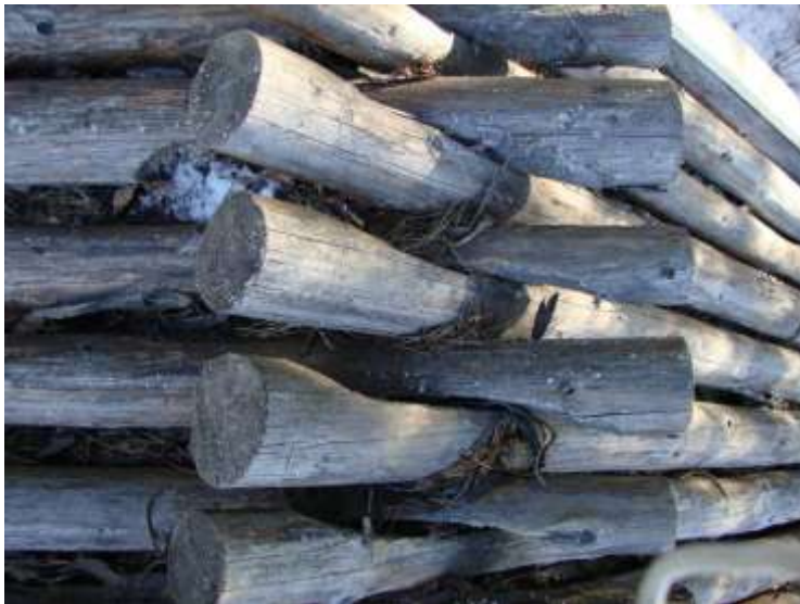
Kuva 9. Malkojen päät on lovettu katon harjalla hanhenkaulalle.
