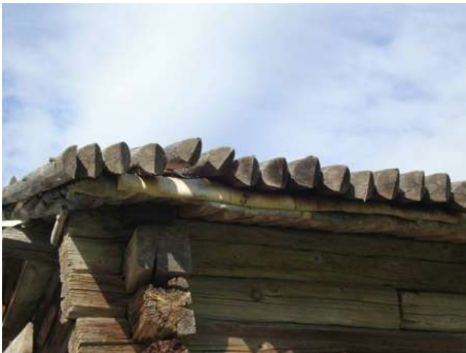
Kuva 17. Tyypillinen ratkaisu museorakennuksessa, eli jokin osa puuttuu. Tässä puuttuva osa on siihirsi. Turkansaari.
