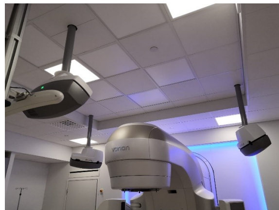
KUVA 4. ja 5. Catalyst®-pintatunnistejärjestelmän projektiyksikkö ja kolme kameraa sijoiteltuna kattoon hoitokoneen ympärille (Myller 2021, CC BY-SA).
