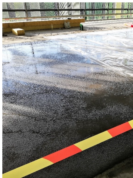
KUVA 7. Kovabetonin jälkihoito (Salmela 2021, CC BY-SA)
