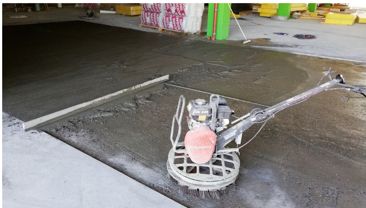
KUVA 5. Kovabetonimassan levittäminen (Salmela 2021, CC BY-SA)
