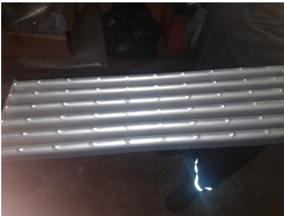
Kuva 10. Lattia-altaan ritilä (Kuva: Olli Eronen).
