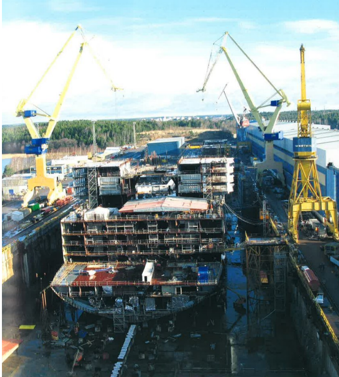
Kuva 6 Rungonkoonti-vaiheessa oleva laiva Turun telakan rakennusaltaalla (T, Pääkkönen. & Haapalainen 2008, 21)
