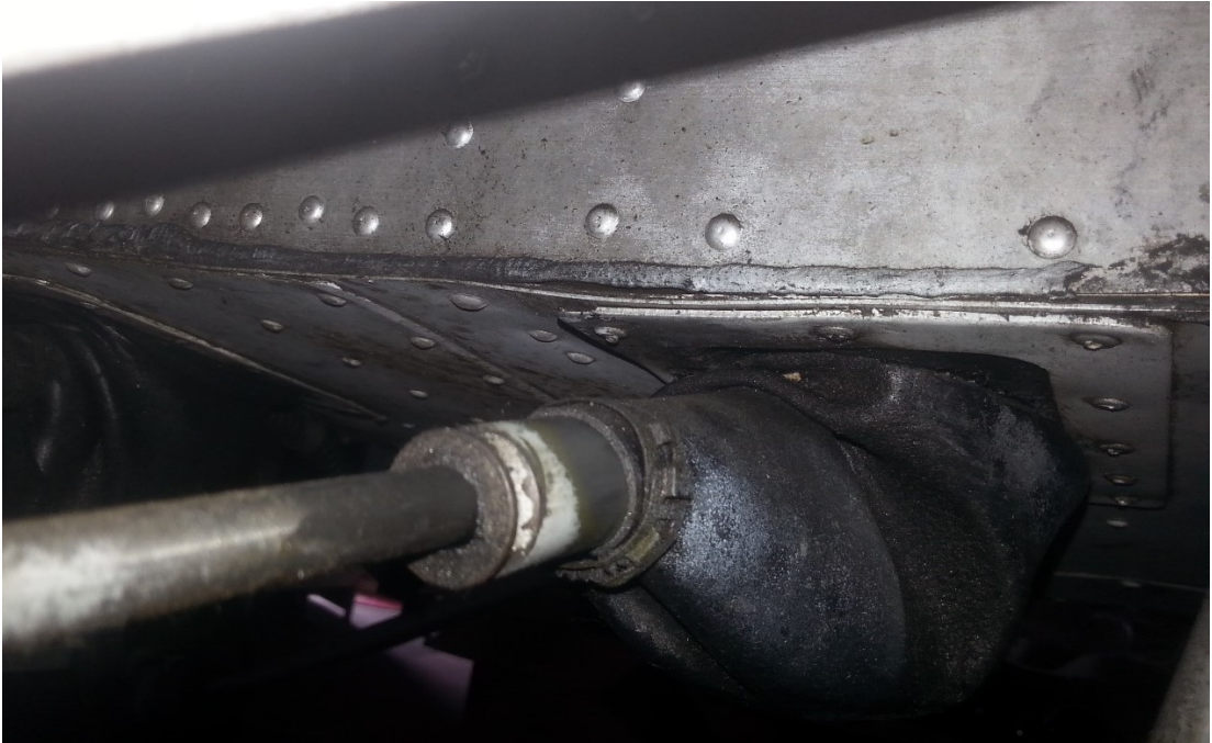
KUVA 22. Pituusjäykisteen, tuliseinän pienen ja lattian välinen rako ulkoapäin (Jokelainen 2018)
