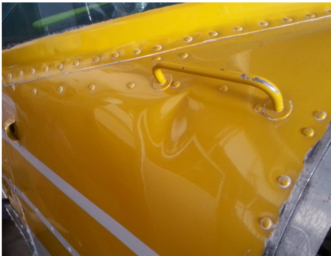
KUVA 15. Rungon molemmilla puolilla olevien lommojen maalipinta on ehjä, eli lommot eivät ole syntyneet suorasta iskusta verhouslevyyn (Jokelainen 2018)
