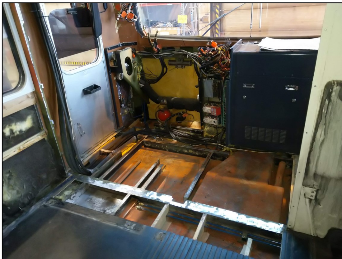
Kuva 5. Purettu ohjaamo. (Myös lattia purettu uusittavilta osin.)
