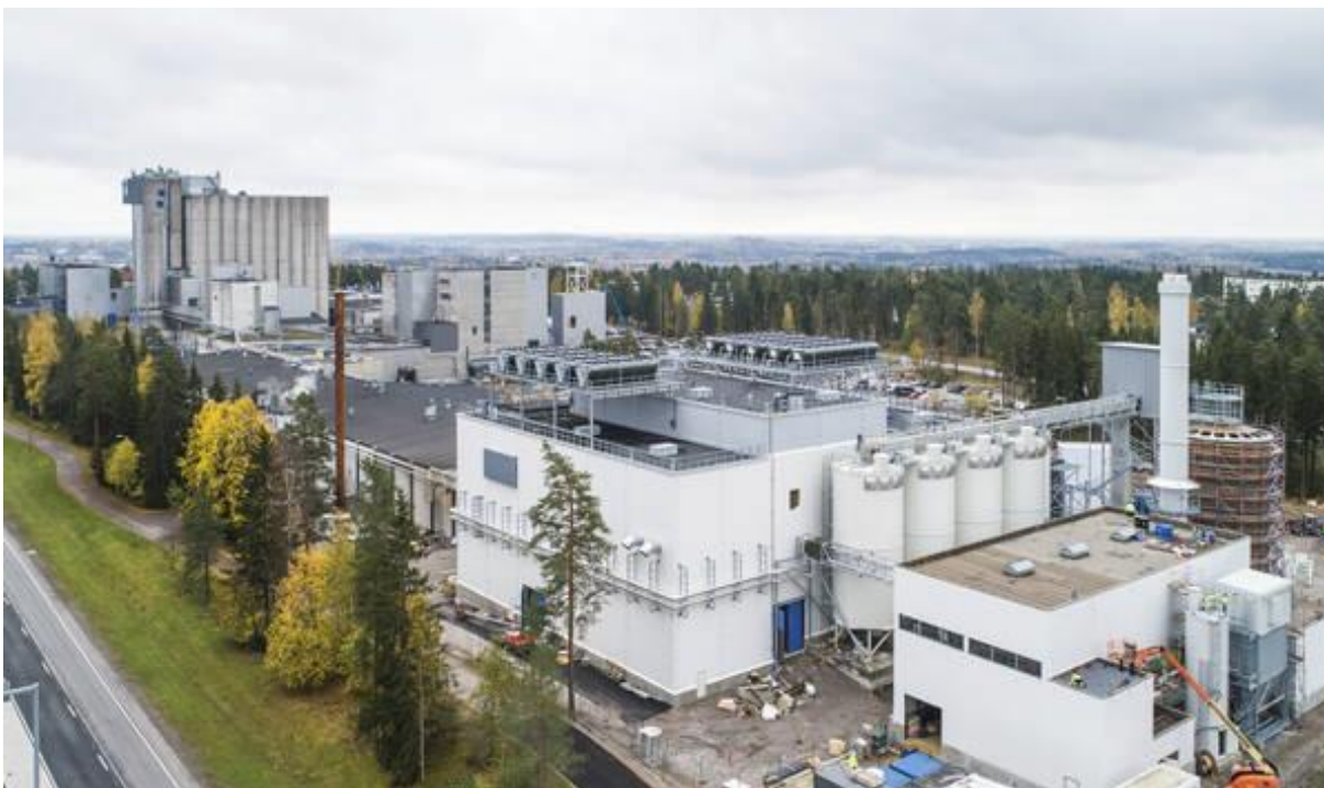
Kuva 1. Lahti Energian biolämpölaitos ksytilitehtaan vieressä (Fazermills)
