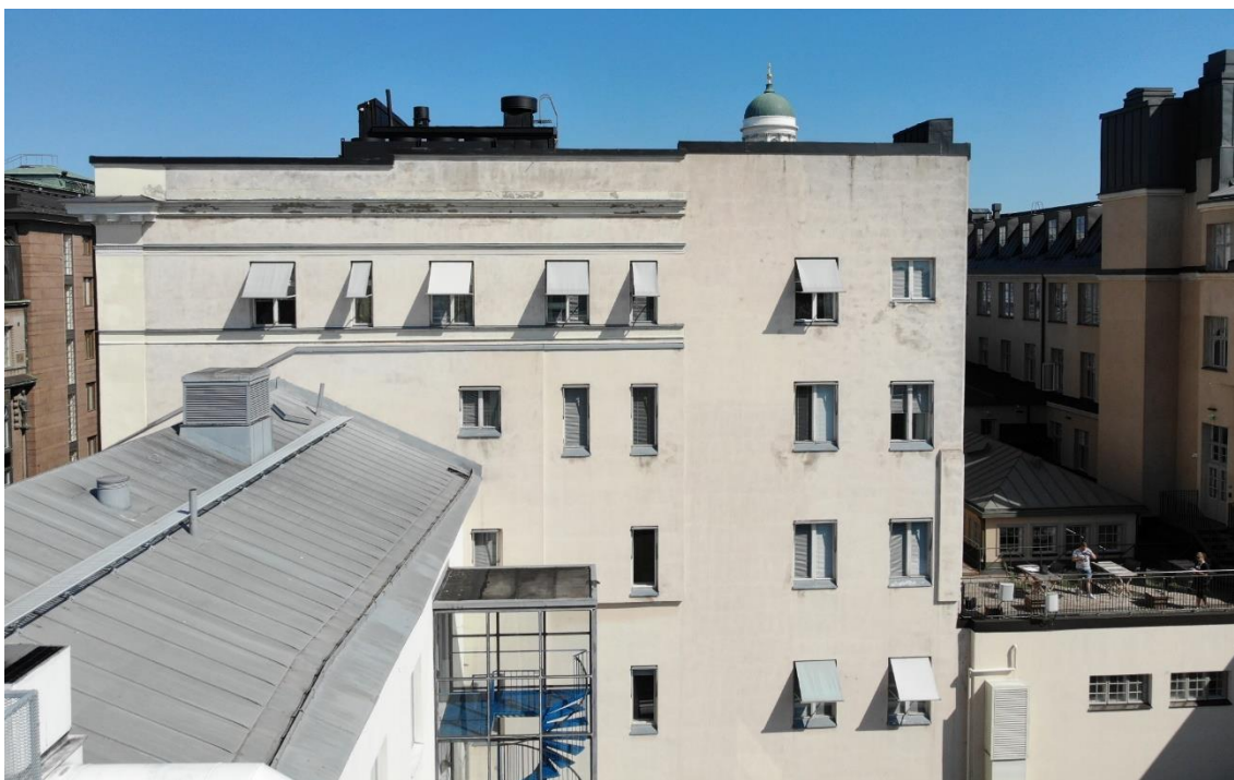
Kuva 9. Yleiskuva rakennuksen julkisivusta. Dronella saadaan kattavampia yleiskuvia, kuin nostimelta tai maan tasalta.
