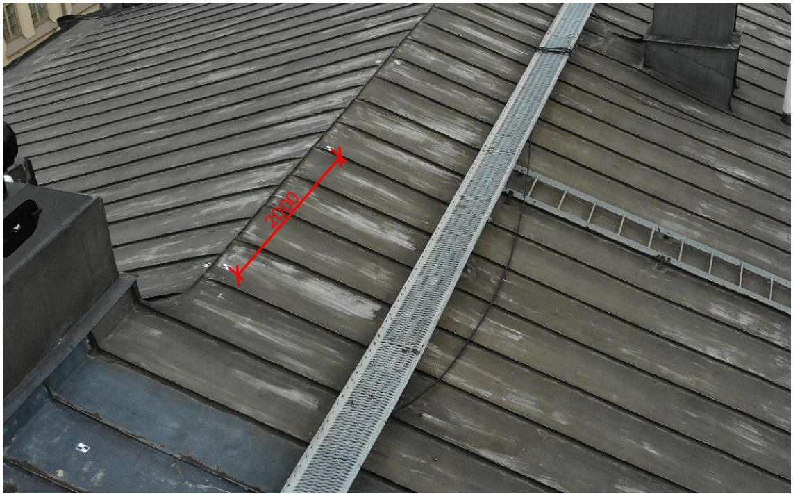
Kuva 12. Katolle kiinnitettiin kohdistustarroja 2 metrin välein harjan tuntumaan jokaiselle katon osalle, jotta jälkikäteen on mahdollista tarkastaa mallinnuksen mittojen tarkkuus.
