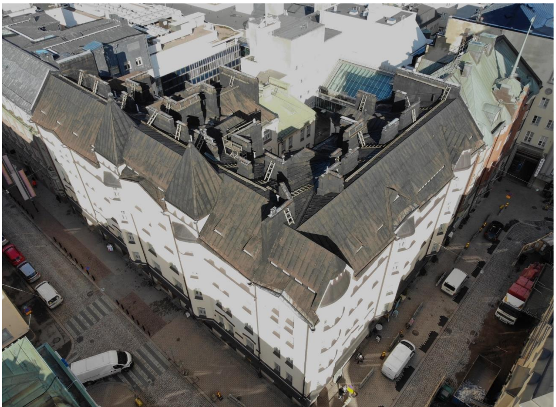
Kuva 1. Yrjönkatu 25 vesikatto, Helsingin keskustan vanhojen rakennusten vesikatot ja julkisivut ovat usein todella monimuotoisia, ja niiden nykytilanteen taltiointiin saadaan suurta apua fotogrammetriasta.
