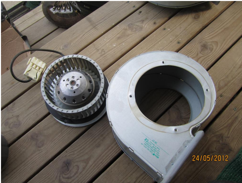
KUVIO 13. Puhallin irrotettuna kotelosta
