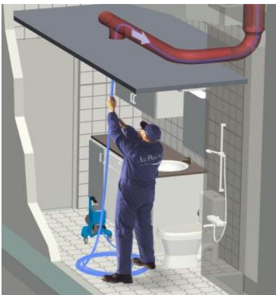
KUVIO 7. Pora-akselia työnnetään kanavaan samalla harjaa pyörittäen (Rääkkylän Pelti- Ja Metallityö Oy, 2011)
