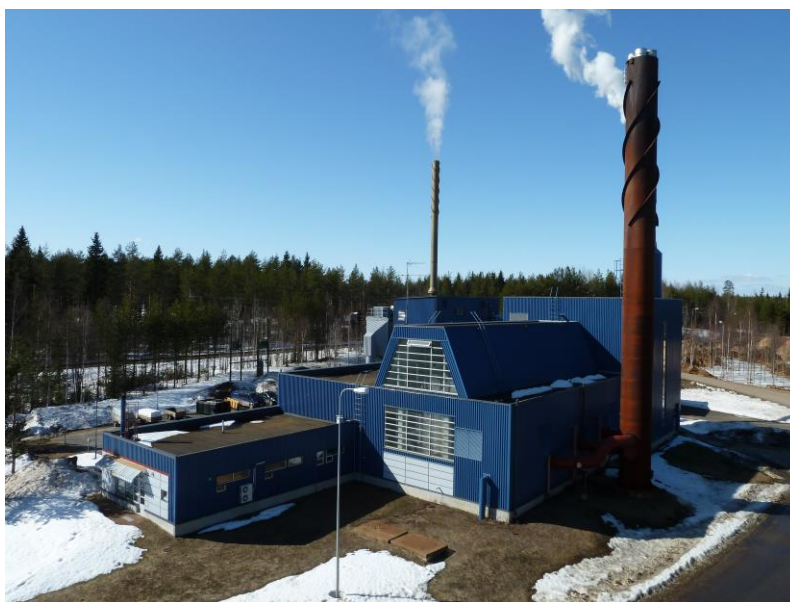
Kuva 3. Miilun lämpökeskus (Okun Energia Oy 2021).
