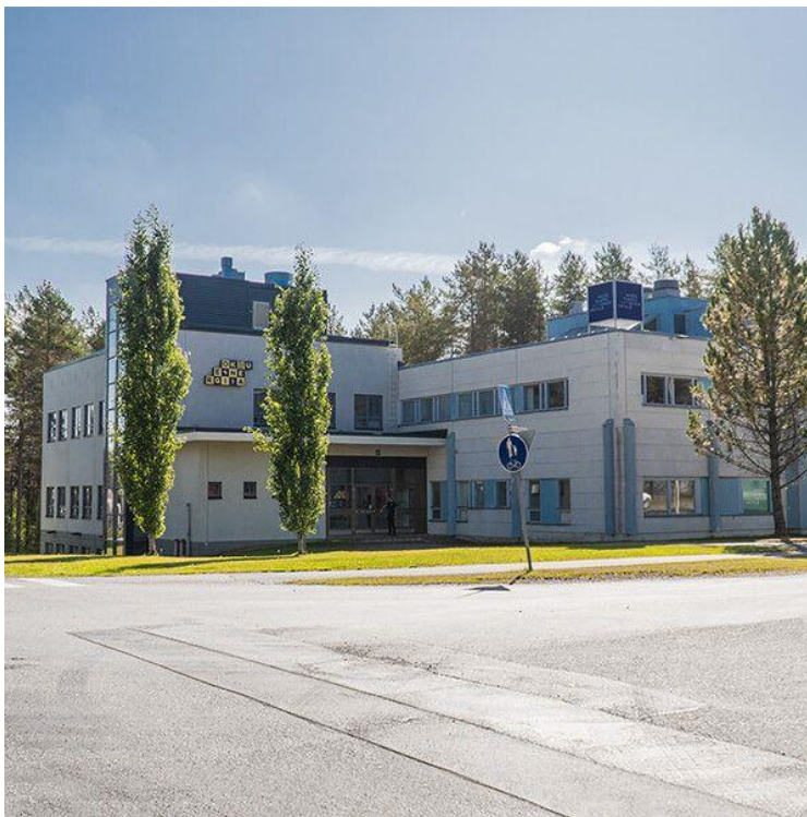
Kuva 1. Okun Energia Oy:n toimistorakennus Teollisuuskylässä (Okun Energia Oy 2019).
