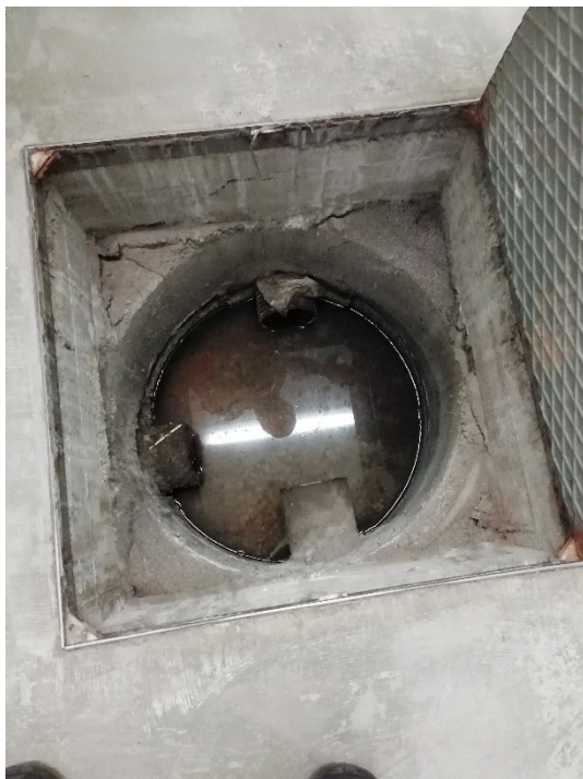
Kuva 15. Vanha salaojan tarkastusluukku (Pärnänen 2019)
