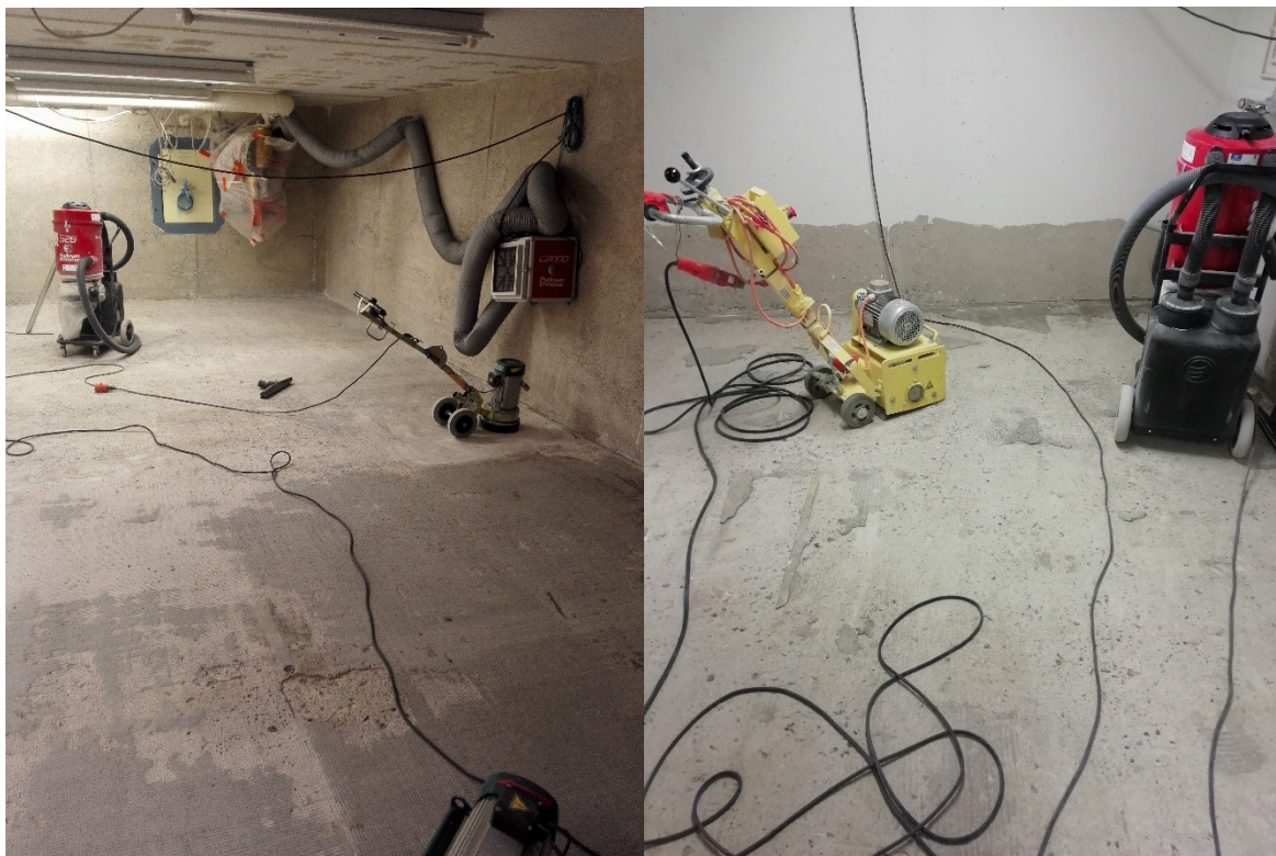
KUVAT 9 ja 10. Betonilattian hiomakone (vasemmalla) ja betonijyrsin (Pärnänen 2019)
