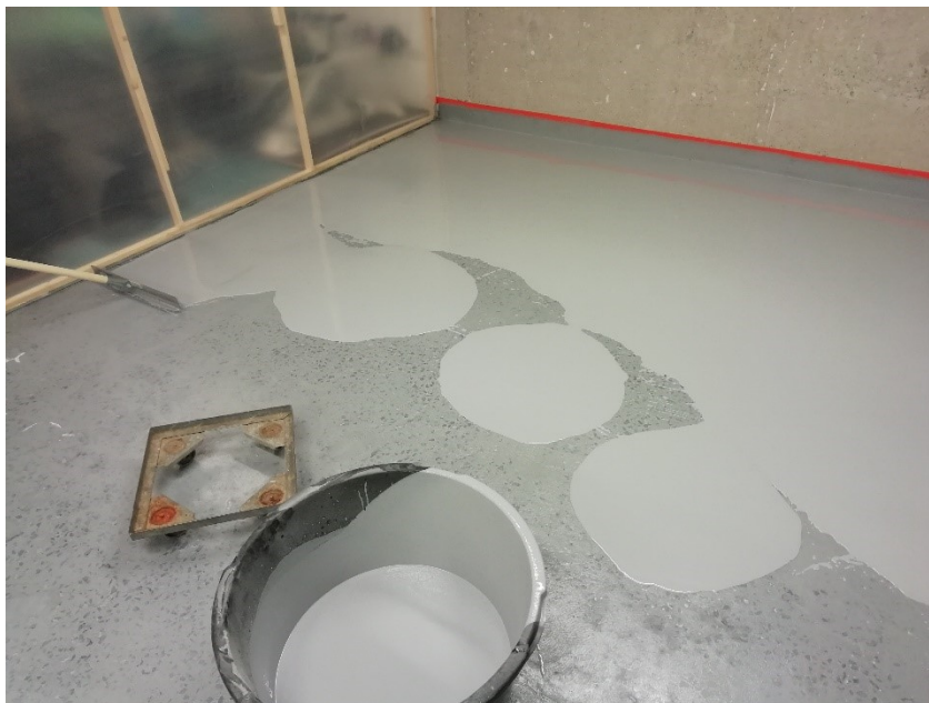
Kuva 13. Mastertop 1730 pinnoitemassa levittäminen säätolastalla (Pärnänen 2019)
