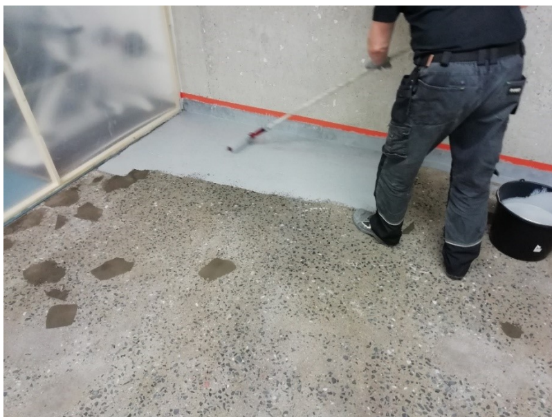
KUVA 11. Mastertop 1730 pohjusteen levittäminen teliaamalla (Pärnänen2019)
