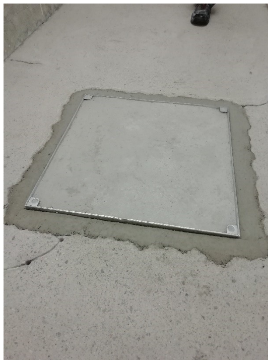
Kuva 16. Uusi kaasutiivis tarkastusluukku (Pärnänen 2019)
