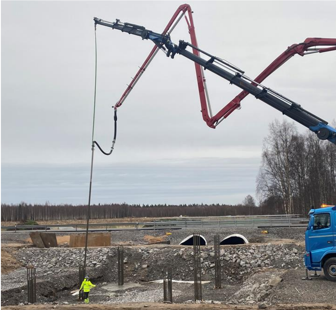
KUVA 4. Paalujen valu ja valuputken käyttö
