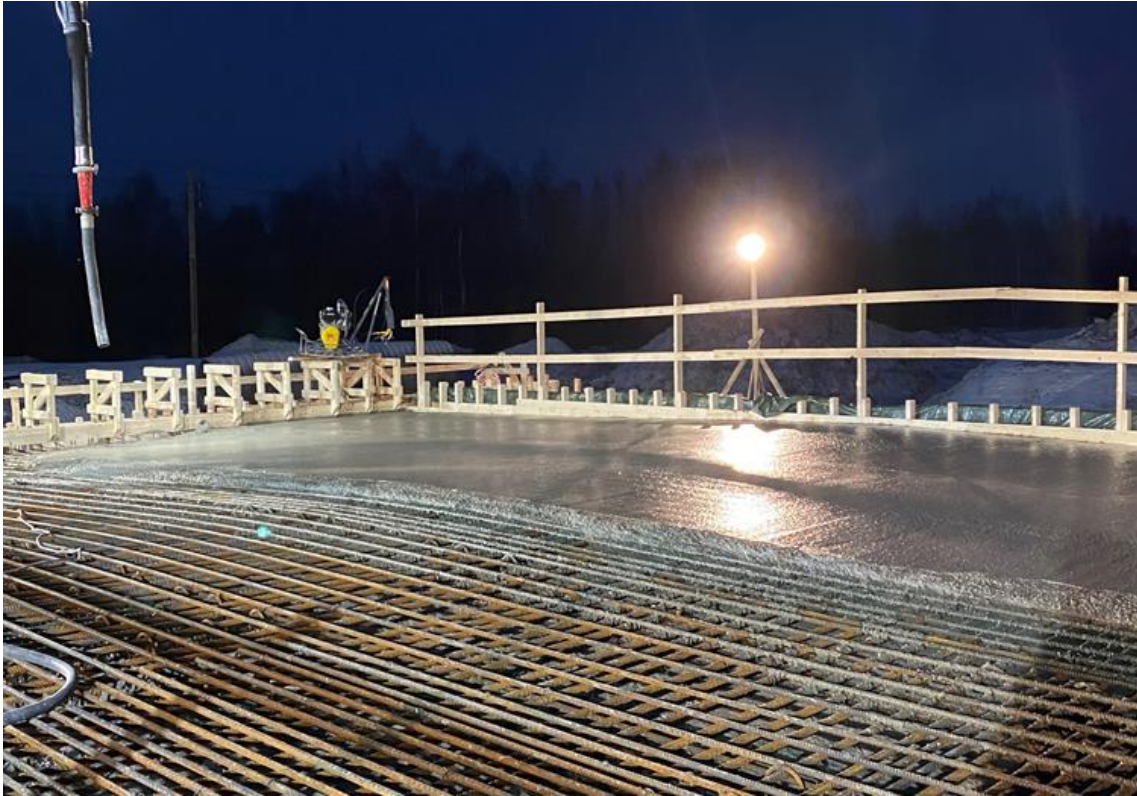
KUVA 7. Sillan päällysrakenteen valu
