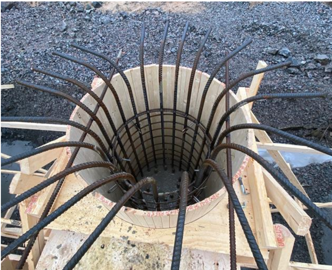
KUVA 6. Pilarimuotti ja pilarin raudoitukset
