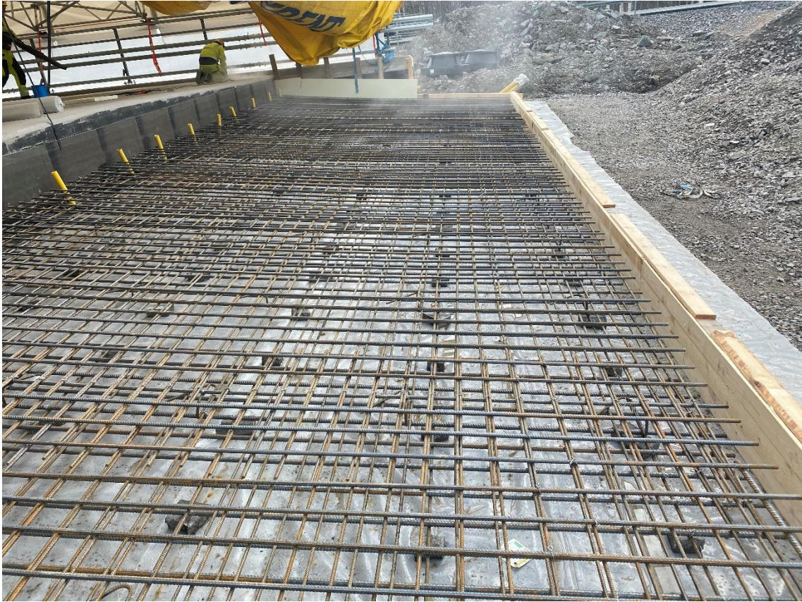
KUVA 9. Raudoitettu siirtymälaatta, muotit ja tartuntojen varaukset
