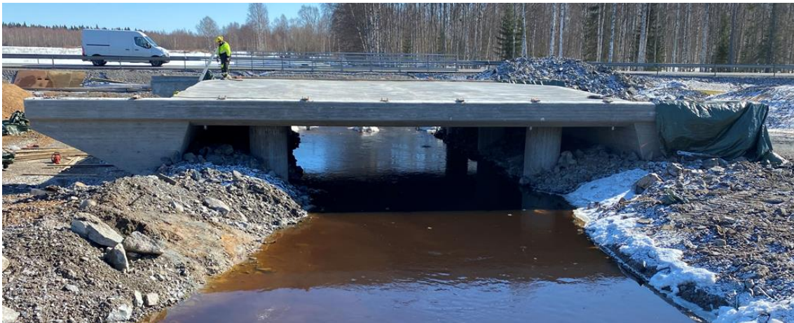
KUVA 2. Harisojan silta, li
