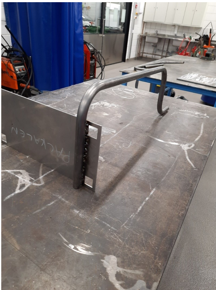
Kuva 11. Ensimmäinen putki kiinnitettynä
