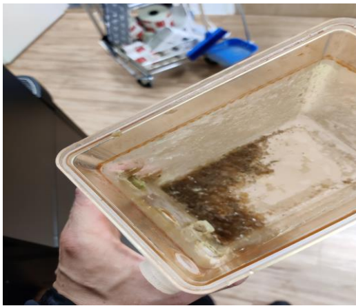
Figur 6, Kalkavlagringar i vattentank i en automat utan filter
