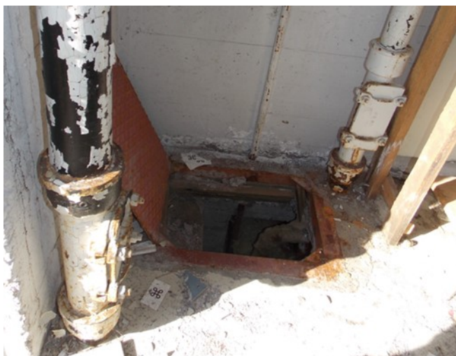
KUVA 5. Lyijyä putkimuhvissa (Heiskanen 2021, CC BY-NC-ND)
