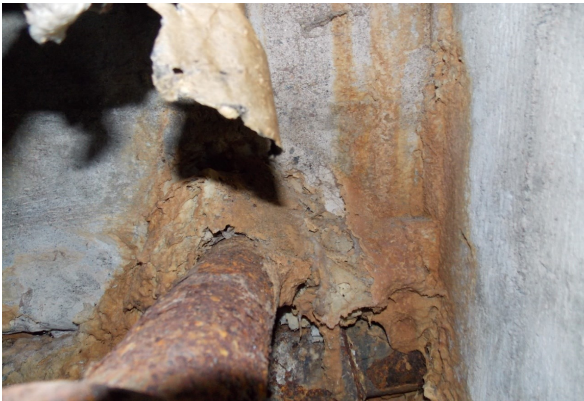
KUVA 4. Asbestin sijainti putkirasioissa (Tumanovich 2021, CC BY-NC-ND)
