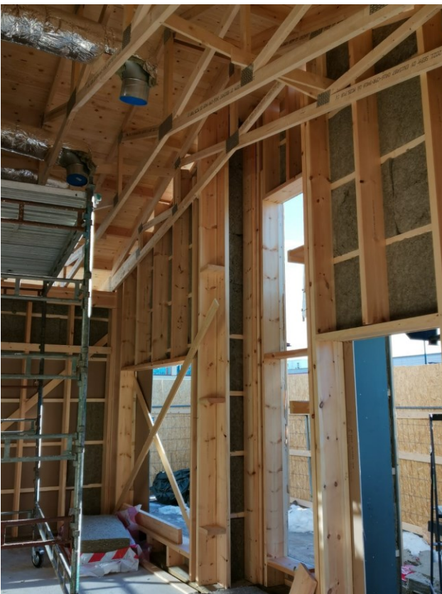
Kuva 7. Laajennusosan runkorakenteita (kuva Pasi Pohjoismäki)
