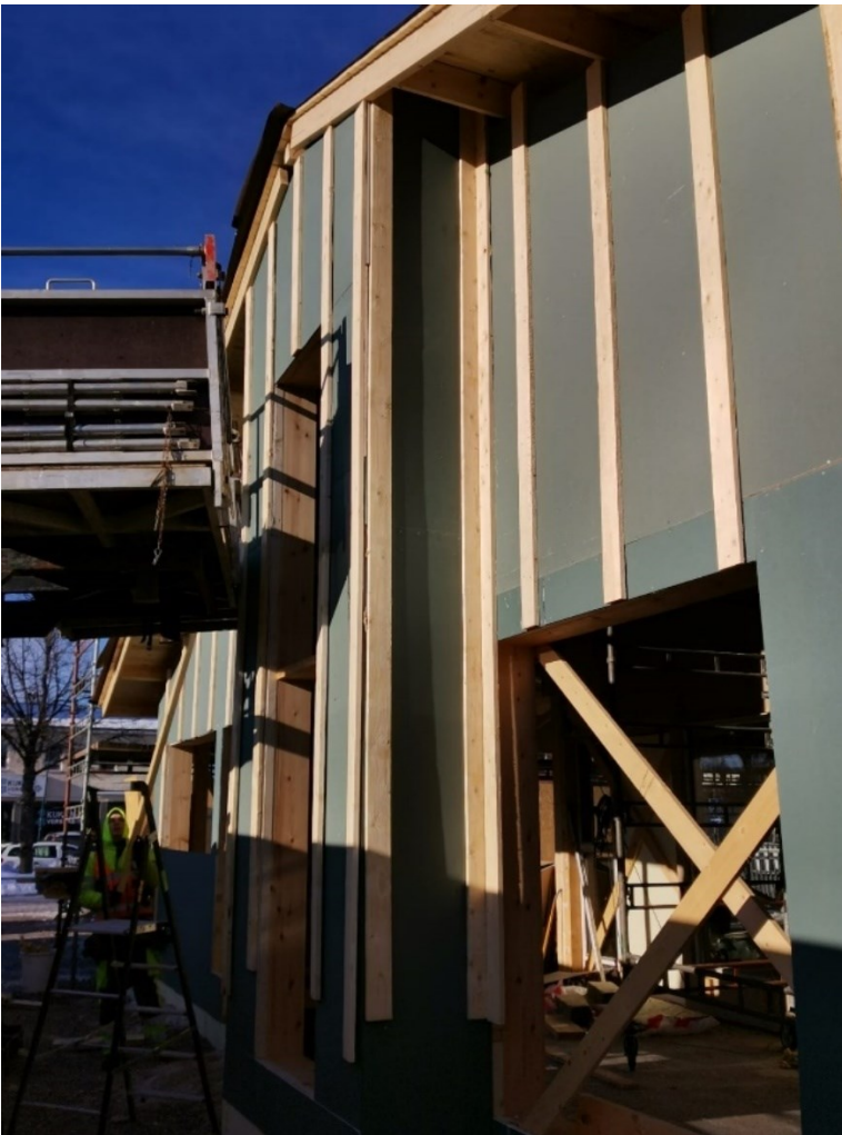
Kuva 10. Ulkoseinien jäykistävää levytystä (kuva Pasi Pohojoismäki)
