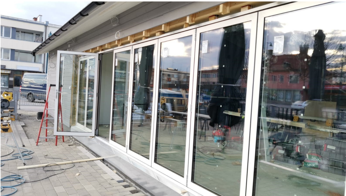
Kuva 6. Lasiliukuseinän asennus (kuva Pasi Pohjoismäki)
