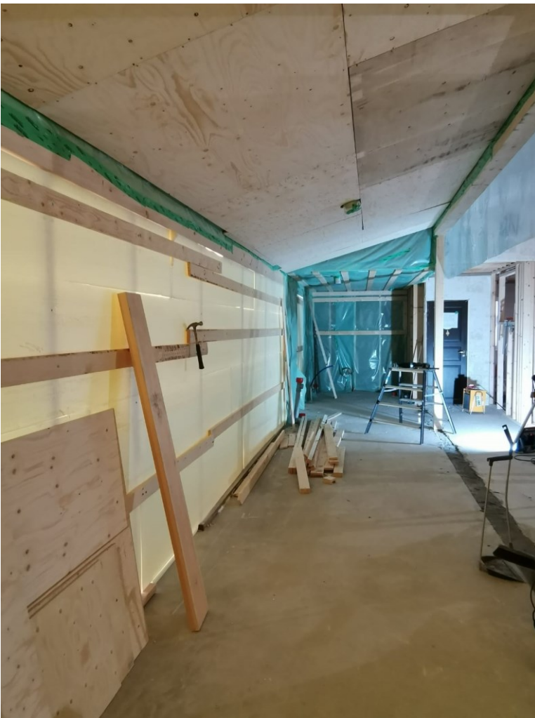
Kuva 9. Laajennusosan yläpohjan jäykistävä vanerilevytys (kuva Pasi Pohjoismäki)
