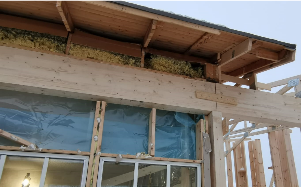
Kuva 3. Pilari-palkkirakenne asennusvaiheessa (kuva Pasi Pohjoismäki)
