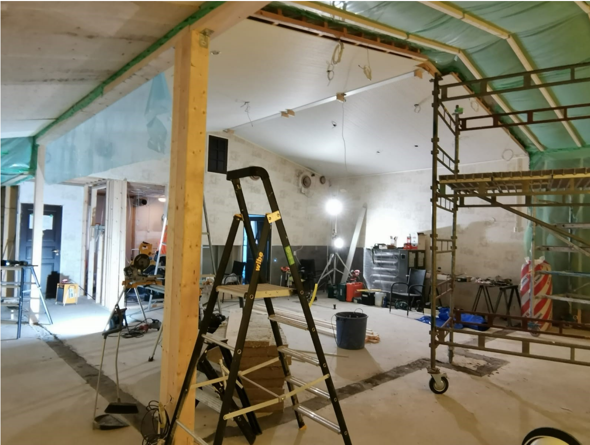
Kuva 4. Sisätilat ulkoseinien purkamisen jälkeen (kuva Pasi Pohjoismäki)
