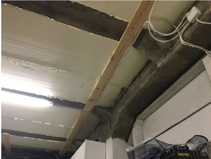
KUVA 31. Lantalasiiven välipohjarakenteita maantasokerroksesta katsottuna.
