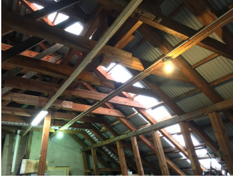
KUVA 26. Navetan yläkerrassa vesikaton kannatinrakenteet sekä entisen katto-lyhdyn sijainti vaaleammassa kohdassa.
