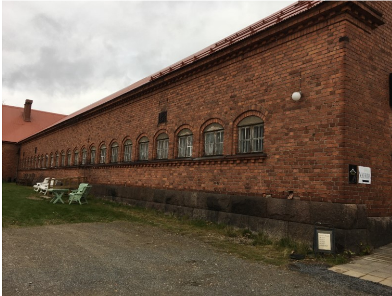
KUVA 25. Sisäpihalta tallisiiven lounasjulkisivu, jonka pitkä ulkoseinä on todennäköisesti kantava.
