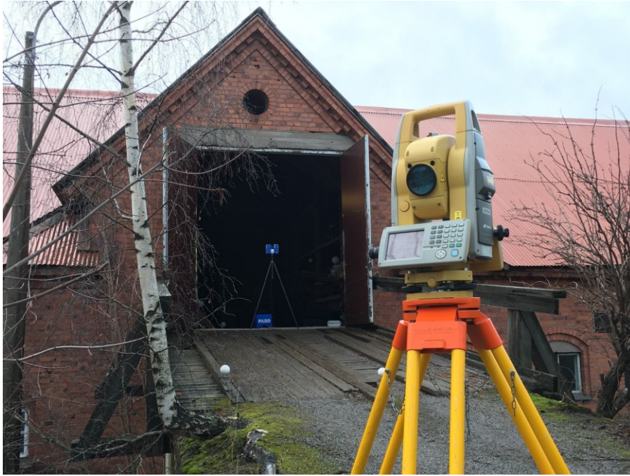
KUVA 38. Navetan sisäänkäynnin edessä oleva takymetri ja ovien luona laserkeilauskoje.
