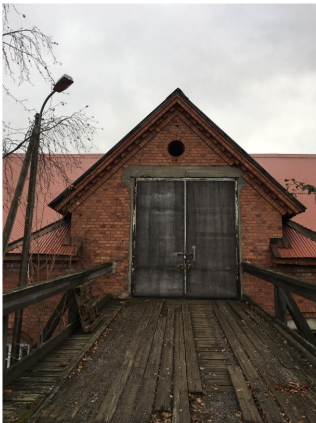
KUVA 18. Koillispuolella on navetan yläkerran pääsisäänkäynti, jossa on puinen luiskasilta.
