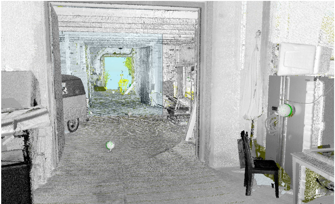
KUVA 41. Navetan sisätilasta tuotettua pistepilviaineistoa.
