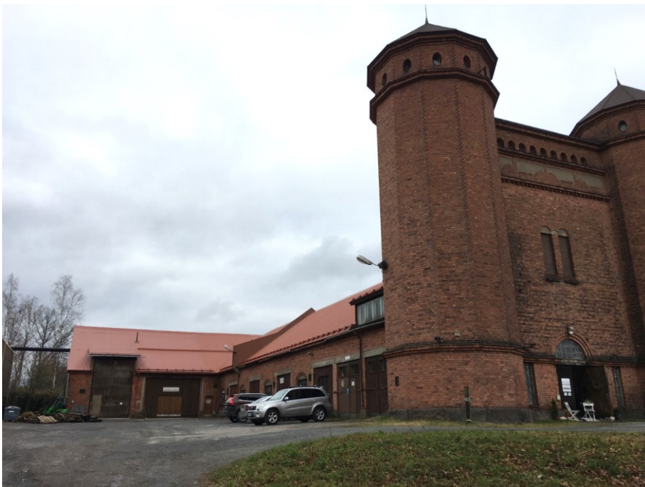
KUVA 14. Niemen kartanoalueen huoltopiha, jossa julkisivuun on puhkottu suuria pariovia paloaseman toimintaan.
