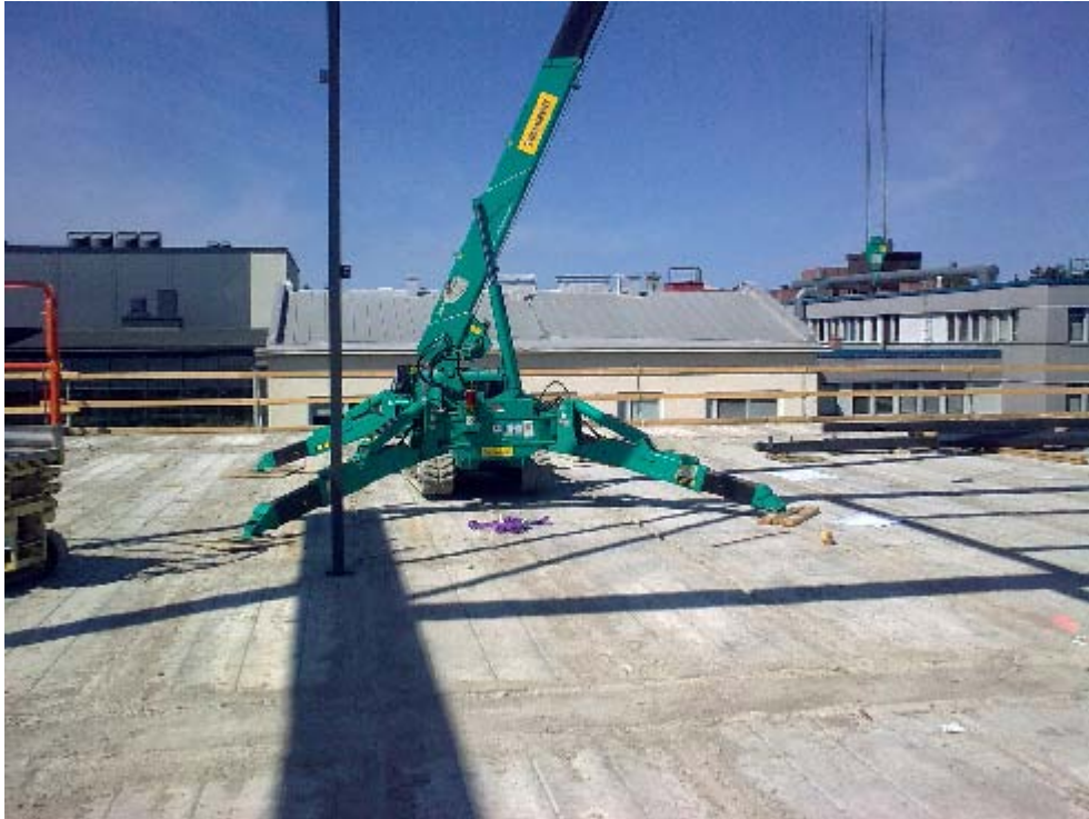
Kuva 6 Asennuksessa käytetty nostin
