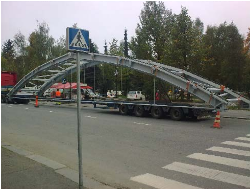
Kuva 1 Teräskaari odottaa nostoa, 10.7.2010
