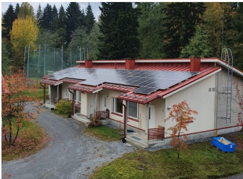
KUVA 3. Asennetut paneelit pienen rivitalon katolla. (Niemeläinen, 2020)
