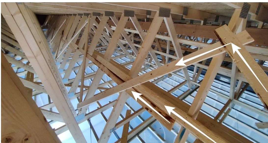
Kuva 24. Kattoristikoiden nurjahdustuentaan käytettyjä lautoja nuolten suuntaisesti. Kuva otettu vasta vesikatteen teon jälkeen, nurjahdustuet on asennettava ennen tätä työvaihetta.
