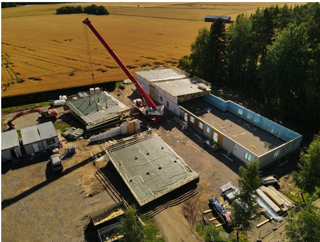
Kuva 19. Kolmannen kattolohkon nosto. Palokatkoristikko maassa kattolohkojen välissä.
