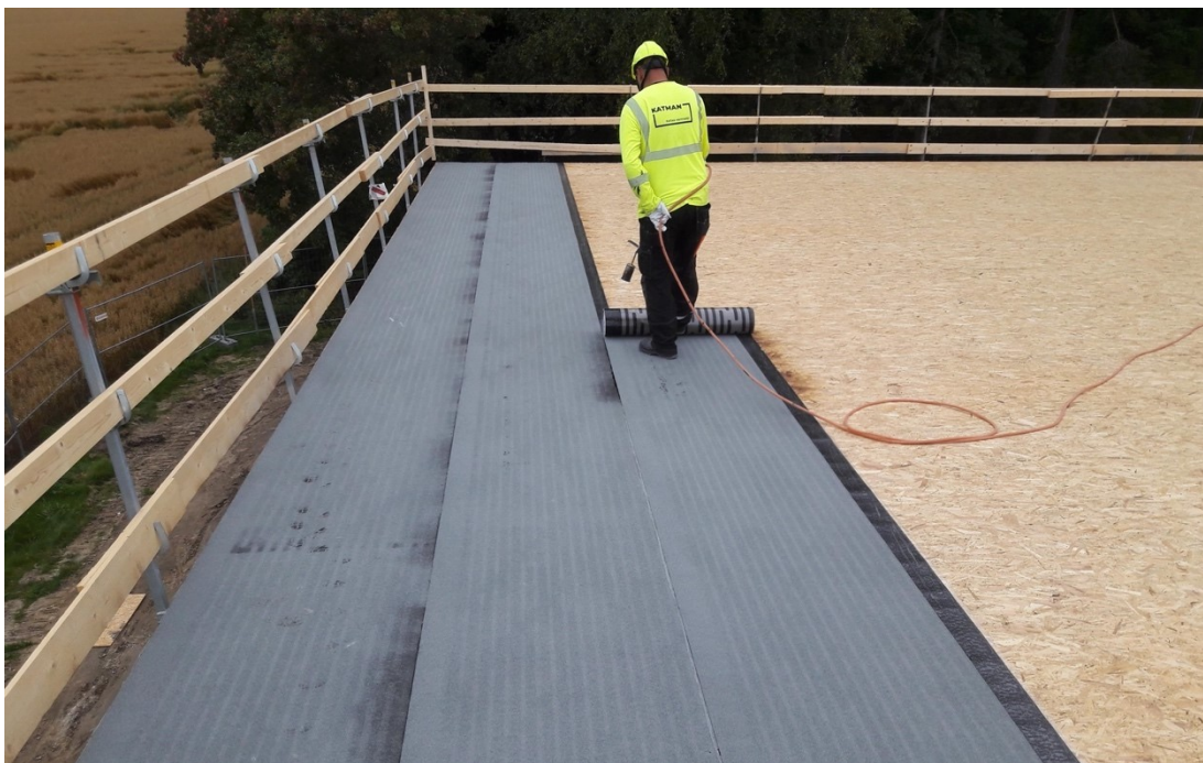
Kuva 9. Alusbitumikermien levitystä OSB-levyn päälle (Uusitalo 2020)
