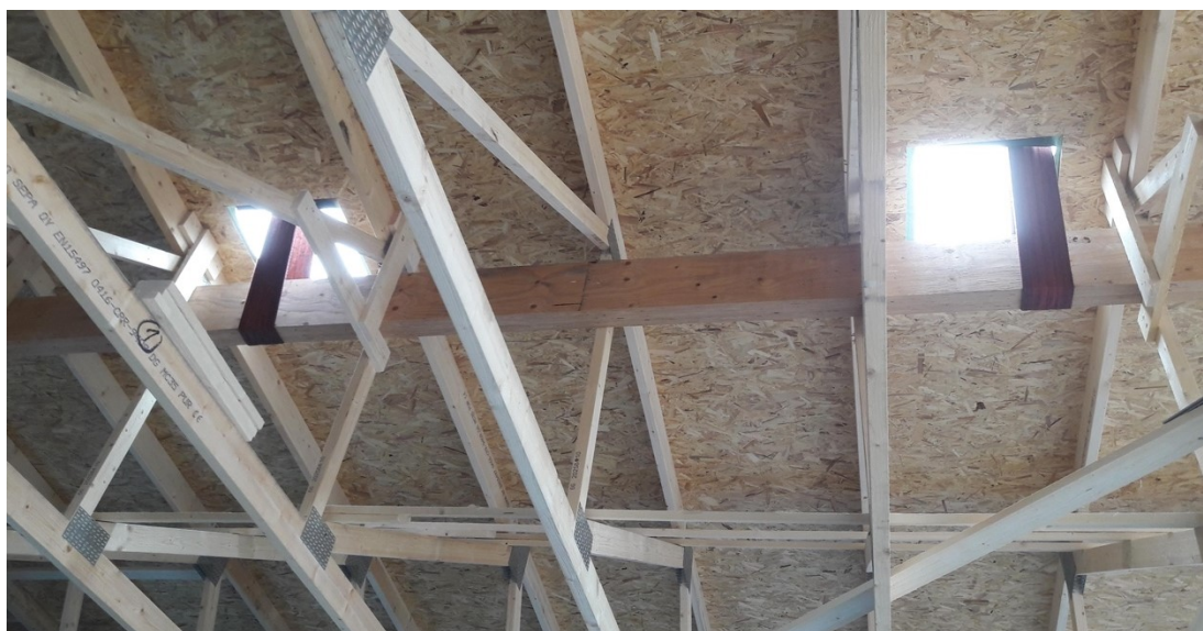
Kuva 16. Nostopalkki asennettuna paikoilleen (Uusitalo 2020)
