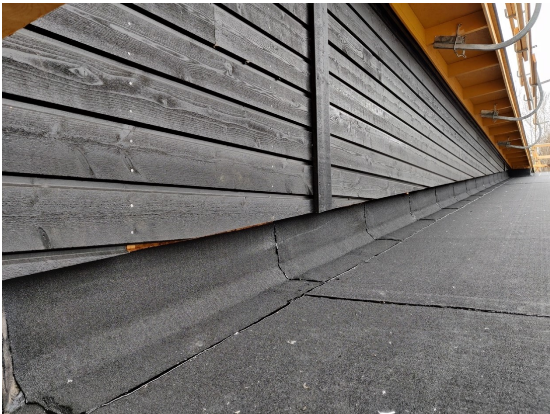
Kuva 11. Bitumikermin ylösnosto. Seinä- ja kattopinnan rajassa bitumikermin alla asennettuna rima, joka muuttaa 90 asteen kulman kahdeksi 45 asteen kulmaksi. Kermin yläreuna on mekaanisesti kiinnitetty julkisivupaneelin taakse OSB-levyyn peltiprofiililla.
