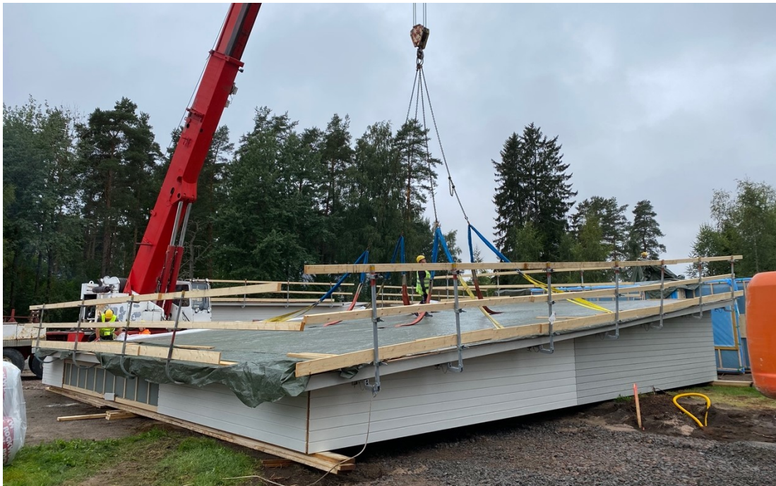
Kuva 17. Kattolohko nostovalmiudessa
