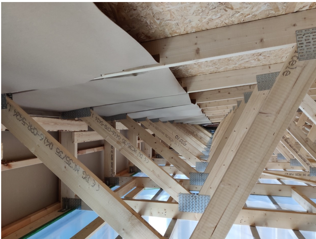
Kuva 6. Yläpohjan tuulenojaimia
