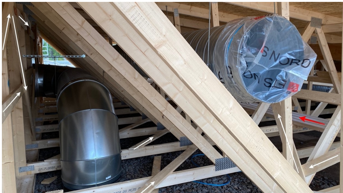
Kuva 15. Iv-kanavat, kulkusillat (punainen nuoli), nurjahdustuennat sekä lisäjäykistykset (valkoiset nuolet) asennettuina vesikattolohkoon ennen nostoa.
