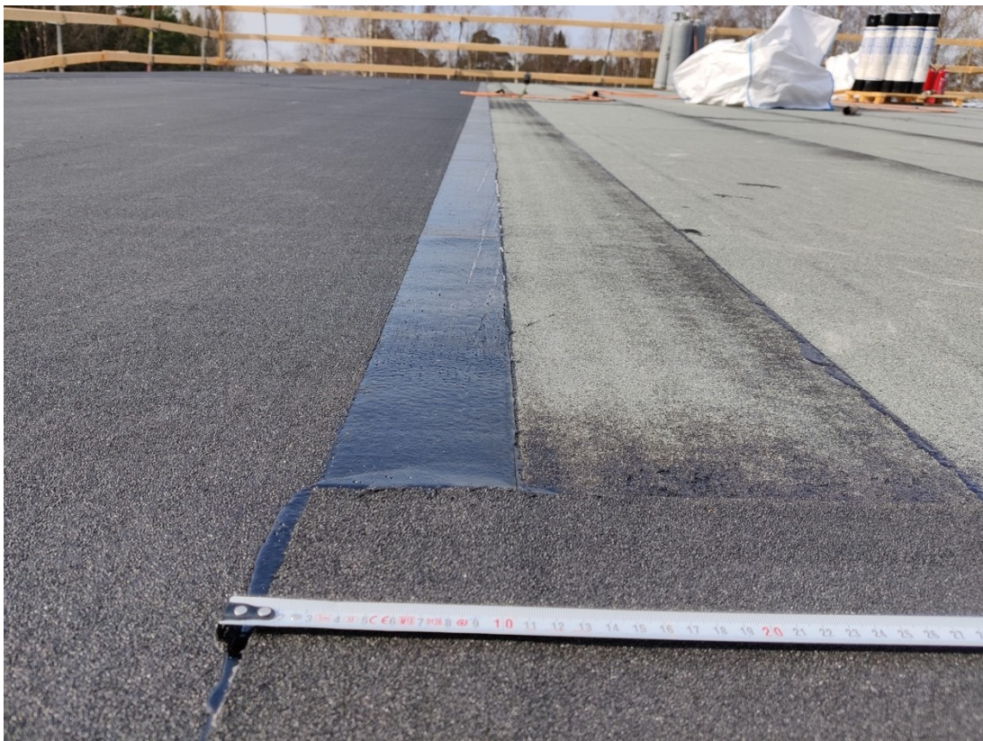
Kuva 12. Aluskermin ja päällyskermin pitkittäinen (sivu) sauma
