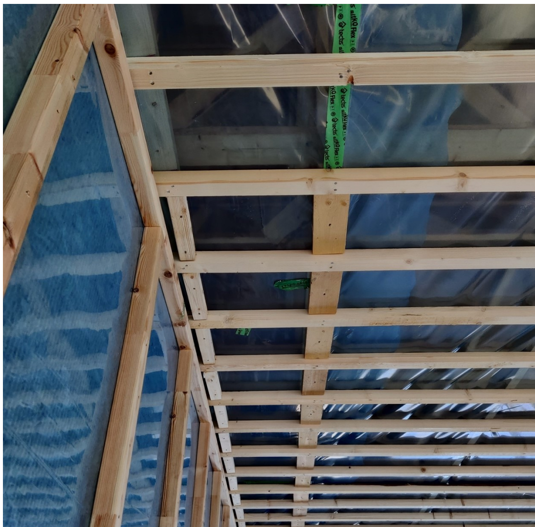
Kuva 5. Höyrynsulkumuovin limitys, teippaus ja puristusliitos
