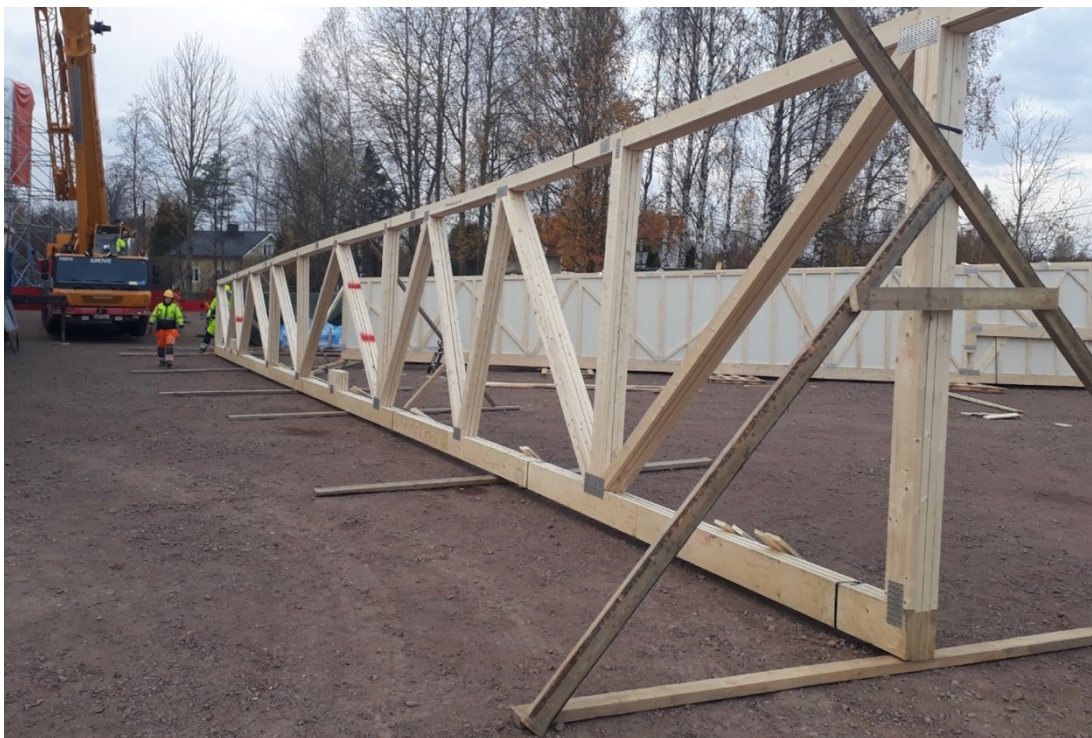
Kuva 1. Nippu NR-rakenteita eli kattokannattajia väliaikaistuettuna (Nivell 2021)
