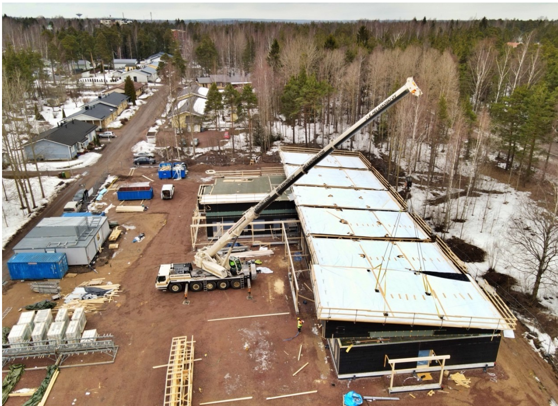
Kuva 21. Viimeisen kattolohkon paikoilleen asennus
