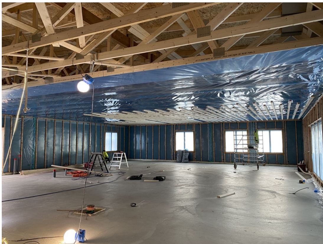
Kuva 4. Höyrynsulun asennusta kattoristikoiden alapaarteeseen
