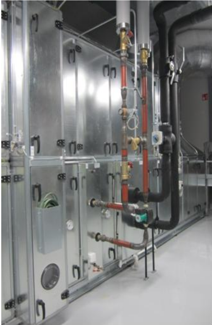
Kuva 5. Asennustapatarkastus ilmanvaihtokoneen lämmitys- ja jäähdytysputkistosta.
