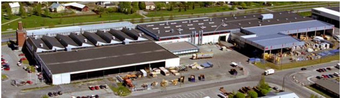
Kuva 1. Fläkt Woods Oy Turku (Fläkt Woods Oy 2011).
