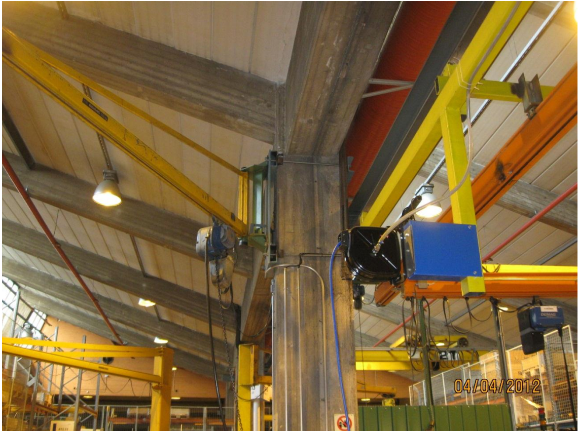
Kuva 14. Nosturin kiinnitystapa
