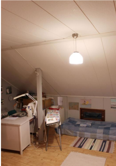
Kuva 63. Työtilan valaisin riippuu vapaana
