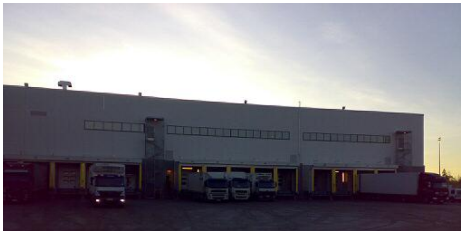
Kuva 5. Postin Logistiikkakeskuksen palveluvaraston laajennus vaihe 5.
