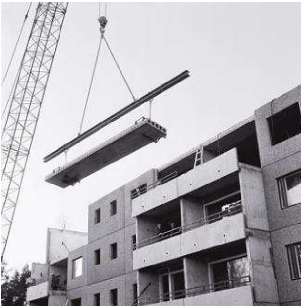
KUVA 7. Ontelolaitan asennus BES-kerrostaloon (BES-rakentamista 70-luvulta lähtien. 2012)
