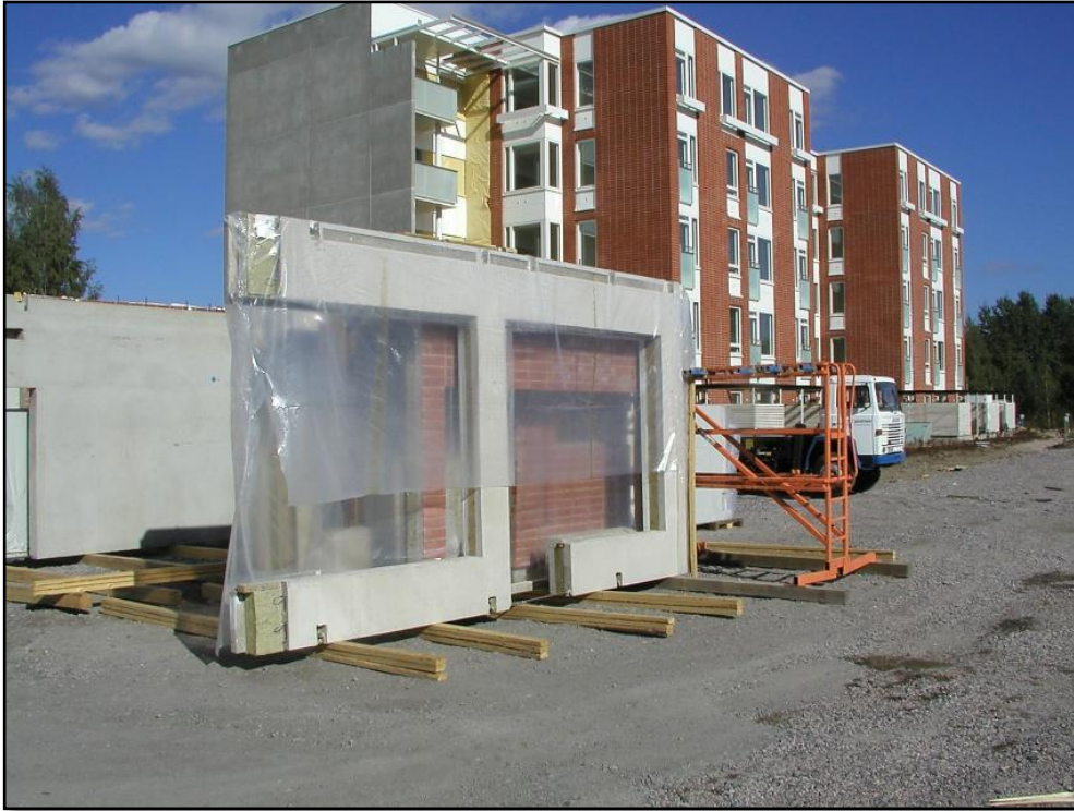
KUVA 1. Tehtaalla suojattu elementti kuljetettuna työmaalle (Teriö 2003, 2)
