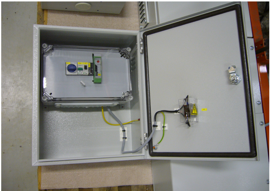
Kuva 11. Polykarbonaattikeskus metallisessa suojakotelossa.
