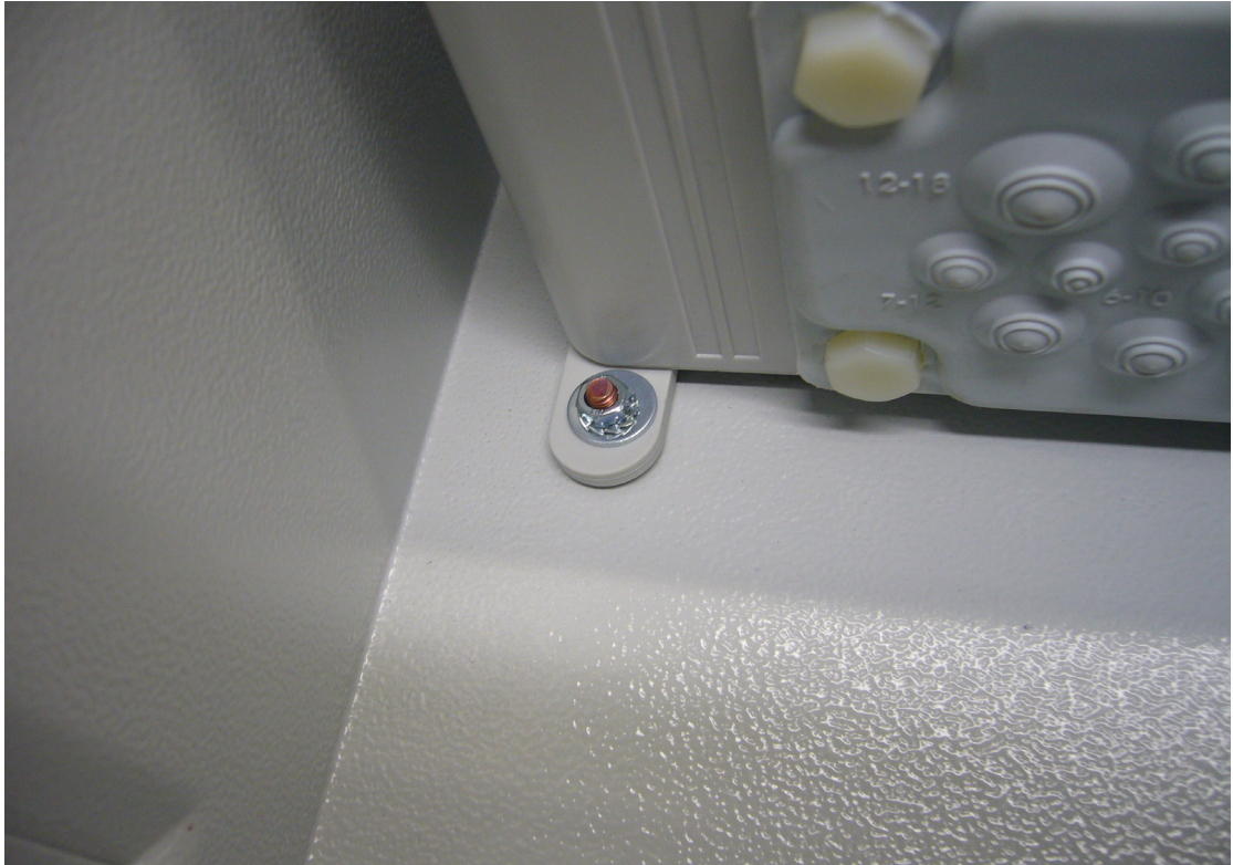
Kuva 8. Sisäkotelon kiinnitys
