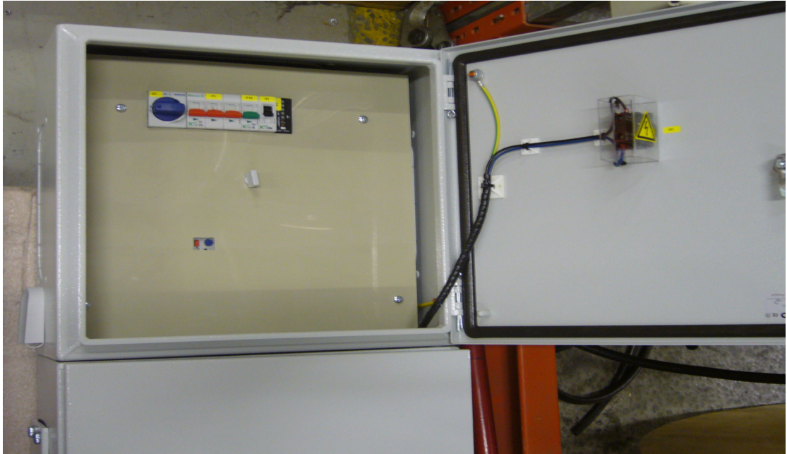
Kuva 10. Keskus lämpöreleellä.
