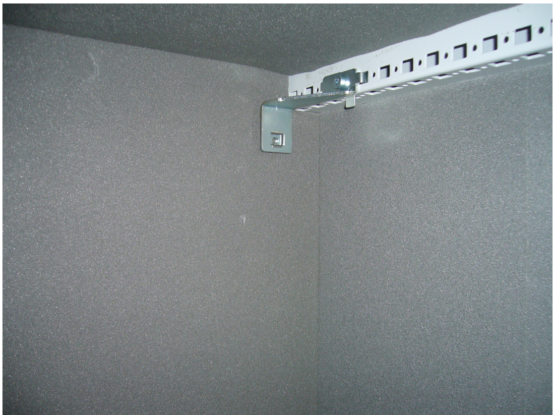
Kuva 3. Asennuslevyn kiinnike lämpöeristetyssä kotelossa.
