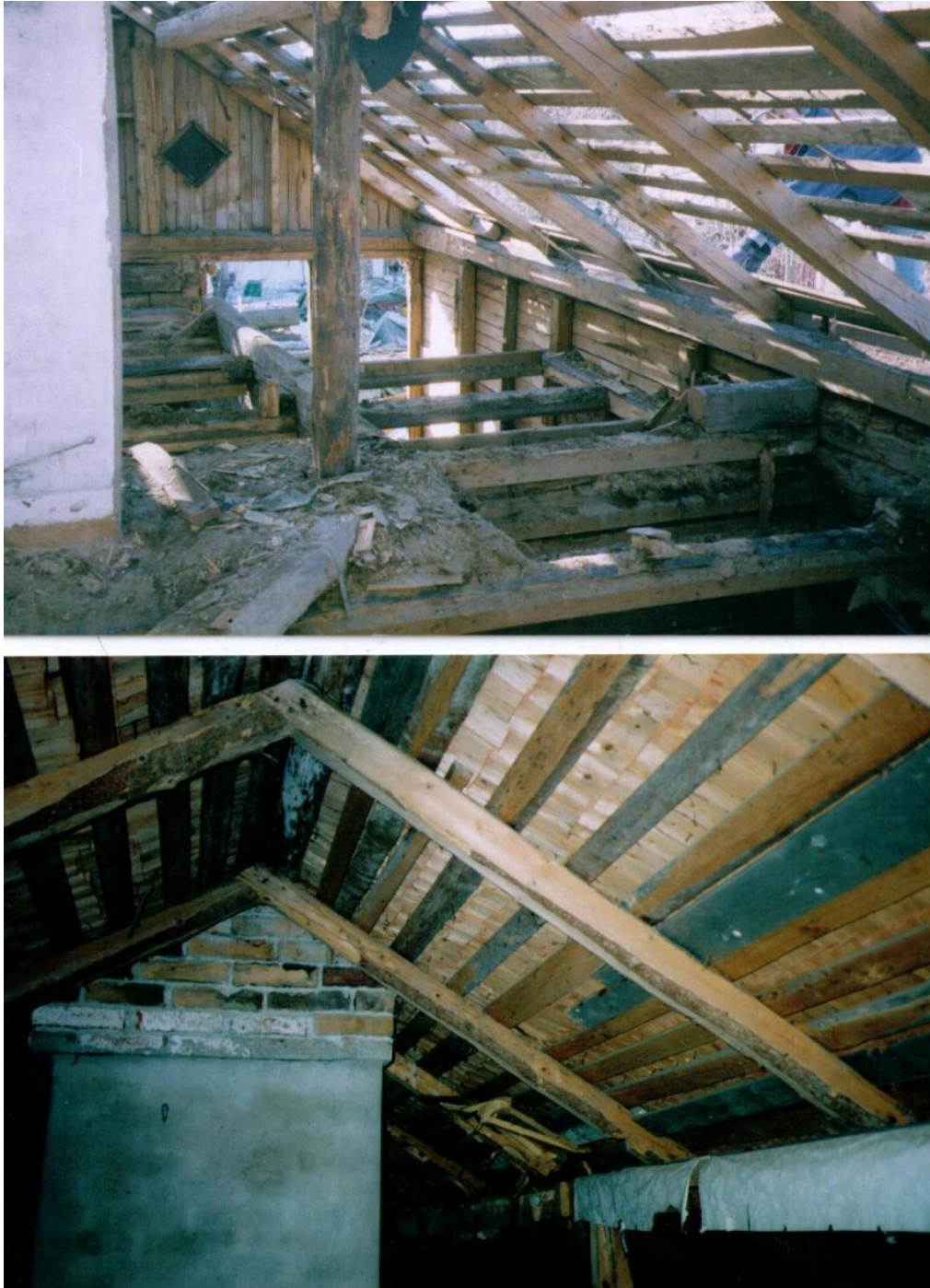
Kuva 16. Purkutalon alkuperäiset vesikattorakenteet. (Kuva: Tilaajan albumi 2004.)
