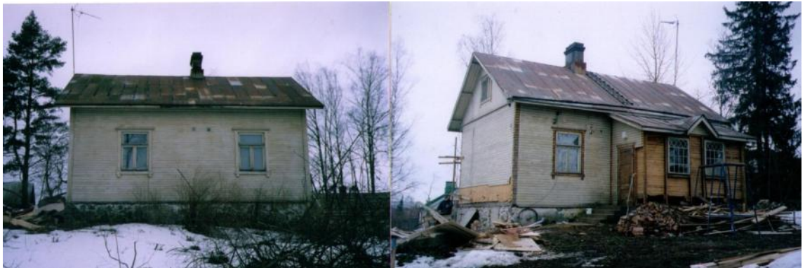
Kuva 1. Talo ennen purkamista. (Kuva: Tilaajan albumi 2004)
