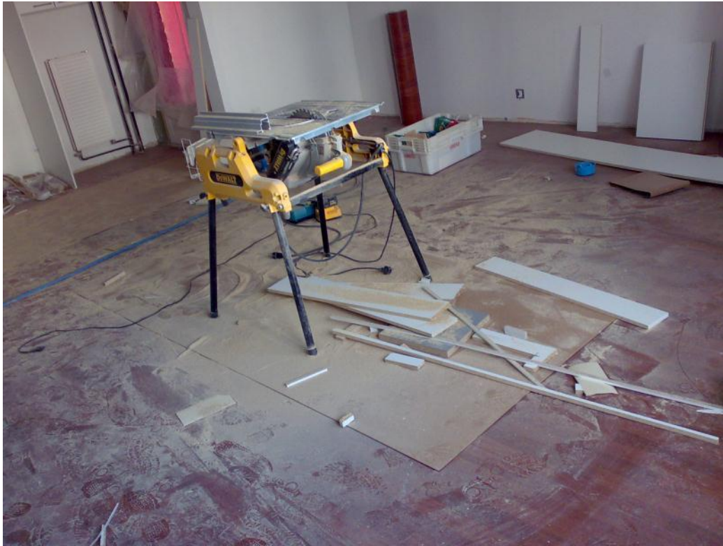
Kuva 8. Valmis mattoasennus rakennusliikkeen puutteellisen suojauksen jälkeen. Kuva Harri Koponen, 2008.
