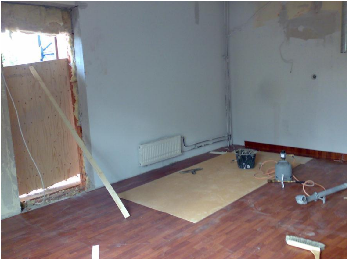
Kuva 6. Työmaa vuodelta 2008 syyskuussa, jolloin kyseisen kuukauden keskilämpötila oli +8 °C. Parvekkeen oviaukoissa oli suojana vaneri. Työmaan (7. kerroksinen kerrostalo) lämmityksenä oli kolme sähköpuhallinta porrashuoneessa. Mattoasennettavassa tilassa oli sama lämpötila kuin ulkona. Kuva Harri Koponen, 2008.
