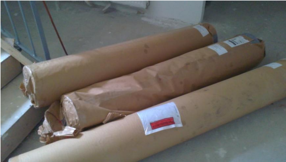
Kuva 12. Mattorullat vaurioituneet rakennusliikkeen vastaanotettua mattorullat työmaalle. Rullat oli siirretty alimpaan kerrokseen viskaamalla ne rappuja pitkin alas. Kuva Harri Koponen, 2011.
