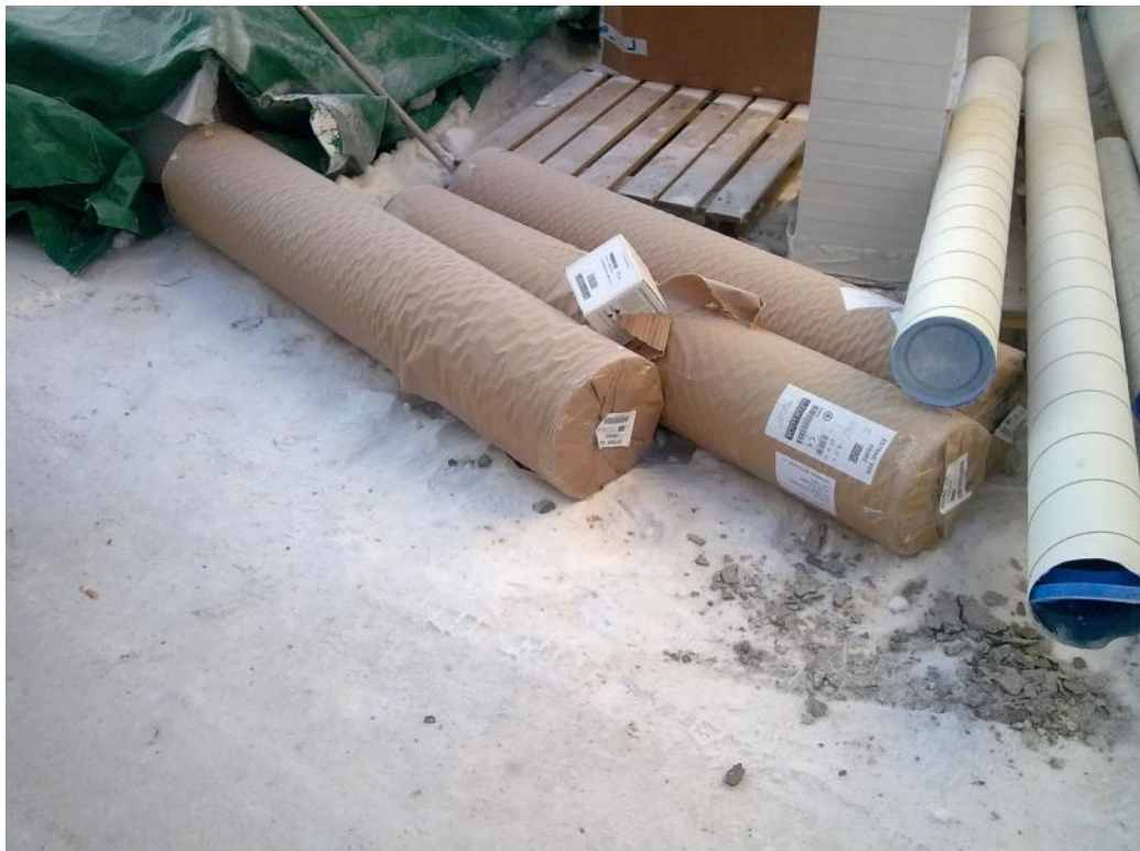
Kuva 11. Rakennusliike vastaanottanut matot työmaalle, mutta jättänyt mattorullat ulos pakkaseen. Kuva Harri Koponen, 2010.
