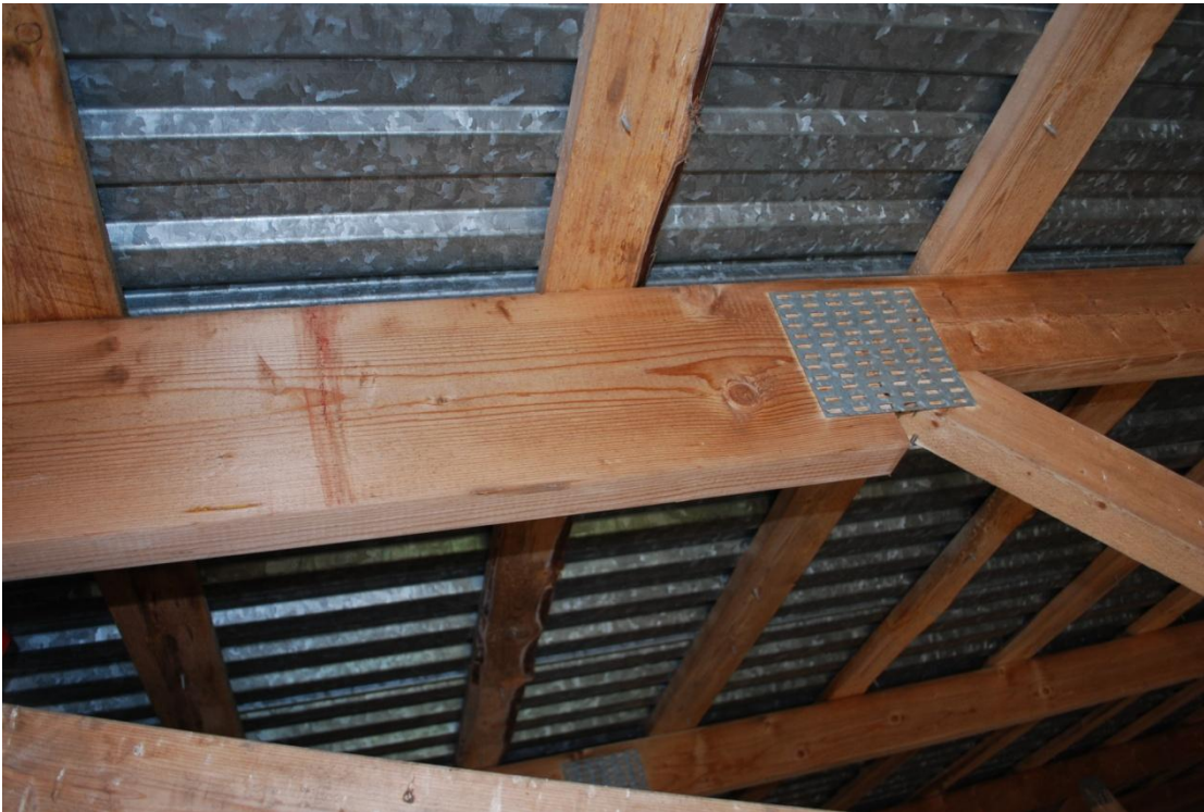
KUVA 2. Kattopeltien kiinnitys. Kattopeltien naulat lävistävät kiinnitysruoteet. Kuva Terho Heikkinen 2012.
