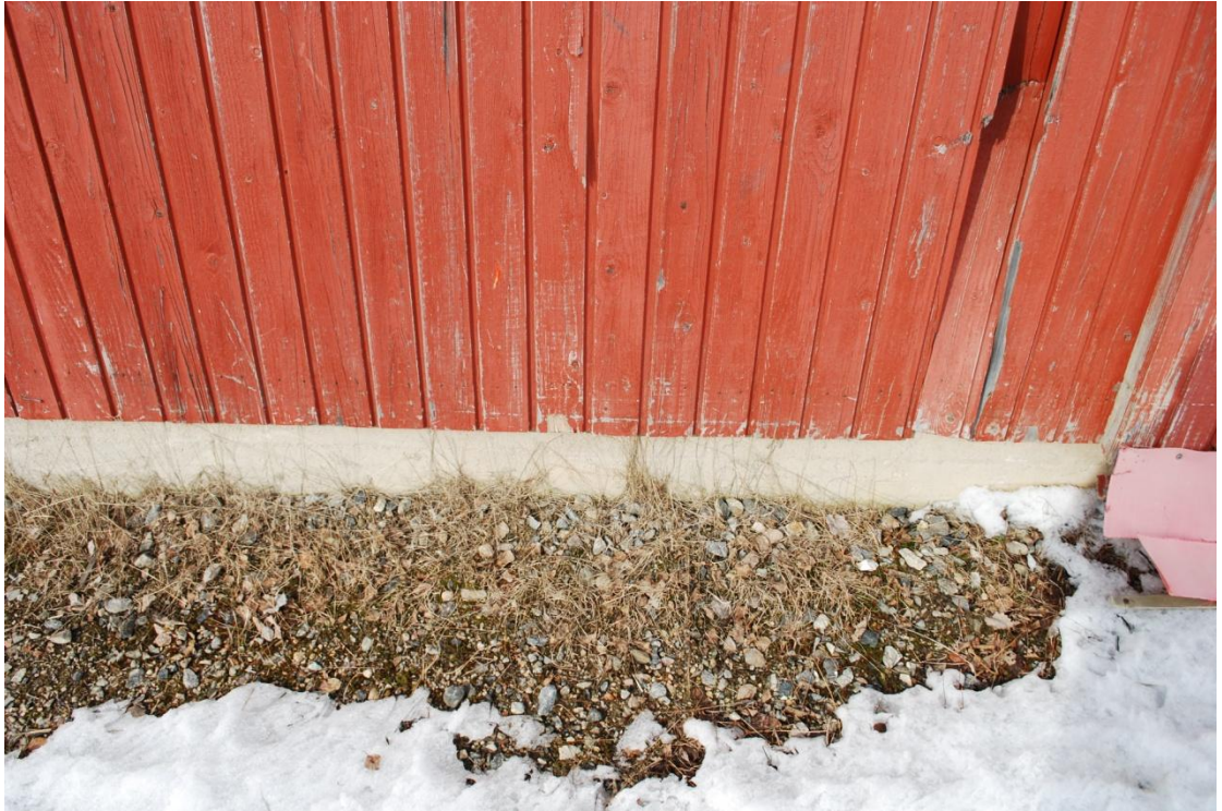
KUVA 4. Ulkoseinän maalipinta itäseinällä. Kuva Terho Heikkinen 2012.
