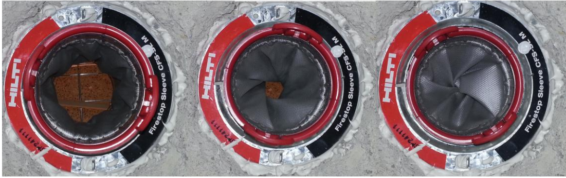
Kuva 6. Hilti –merkkinen avattava palokatko. (Kuvannut: Kimi Pihlajamäki)
