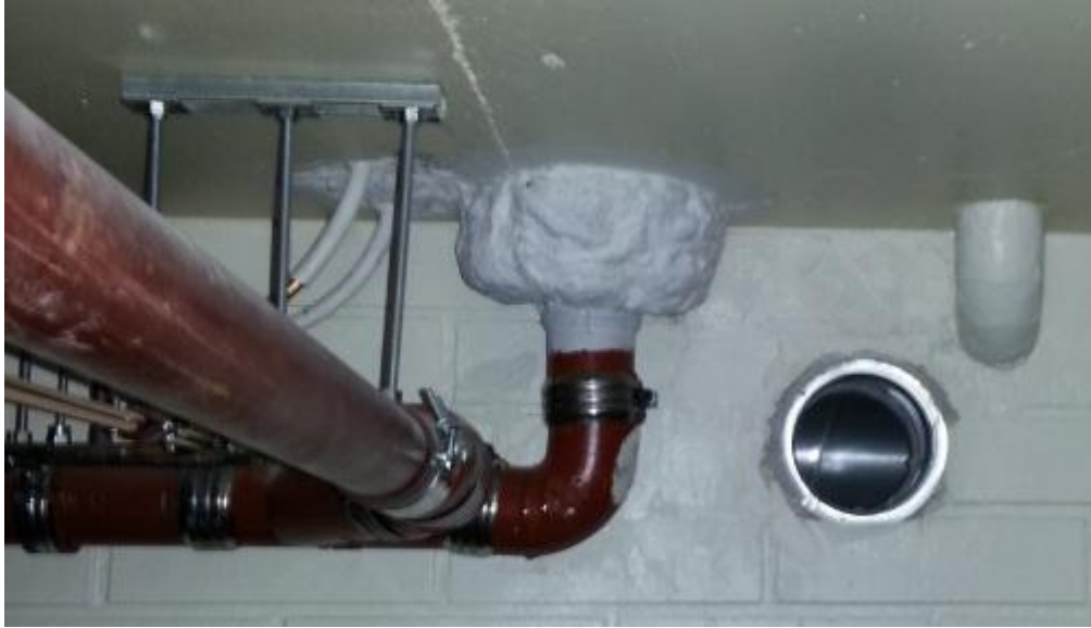
Kuva 8. Viemärin ja vesijohtojen holviläpivienti. (Kuvannut: Kimi Pihlajamäki)
