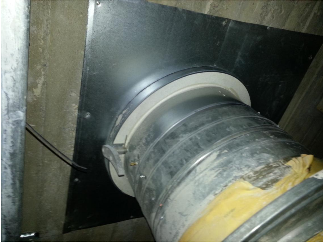
Kuva 14. Osastoivan seinän IV –läpivienti.
