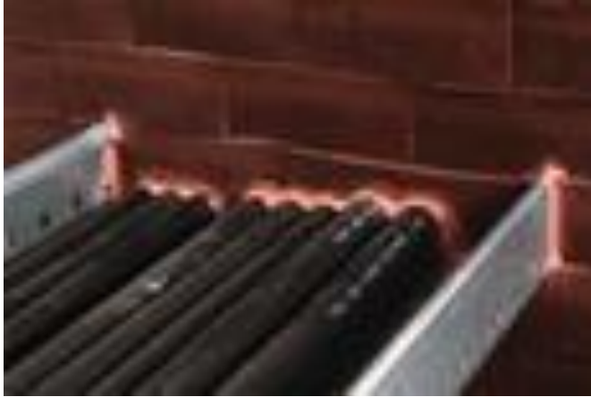
Kuva 5. Palokatkoitiilet toimivat palokatkona kaapeleille. (Hiltin www –sivut 2012)
