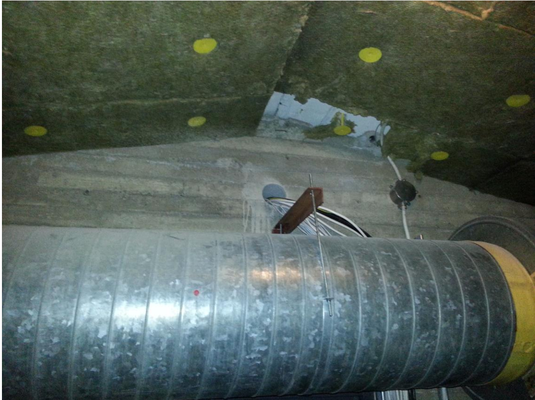
Kuva 13. Pyöreä läpivientiaukko osastoivassa seinässä.
