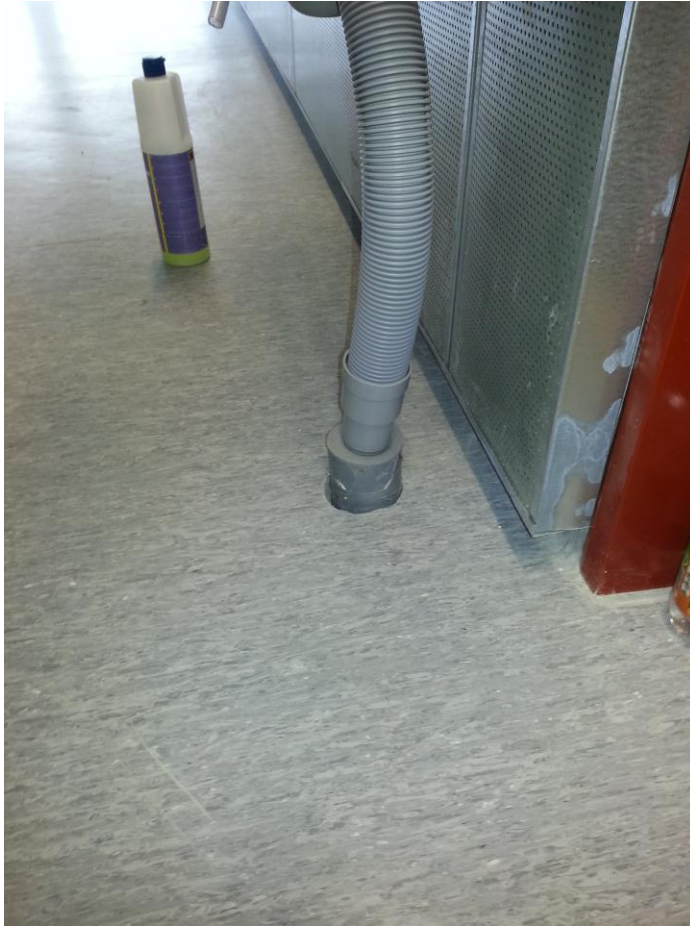
Kuva 15. Osastoivan holvin lävitse tuleva viemäriputki.
