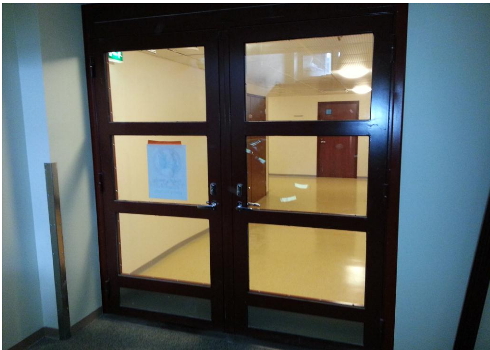
Kuva 20. Uusi palo-ovi.
