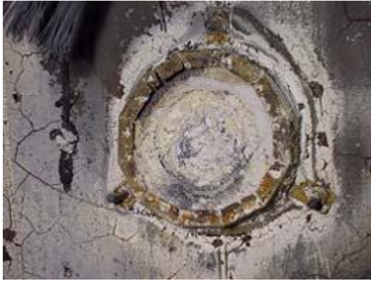
Kuva 1. Palonsuojamansetti estänyt palon leviämisen osastosta. (HB Paloturvan www –sivut 2012)
