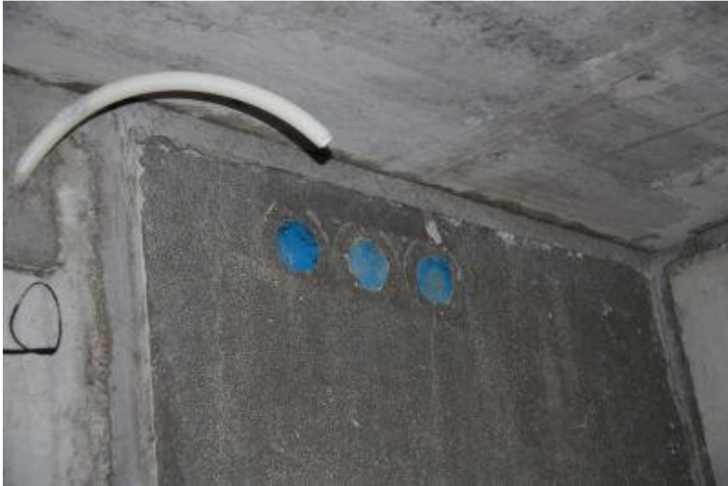
Kuva 4. Esivalmistettu läpivientikappale. (Sewatek www –sivut 2012)
