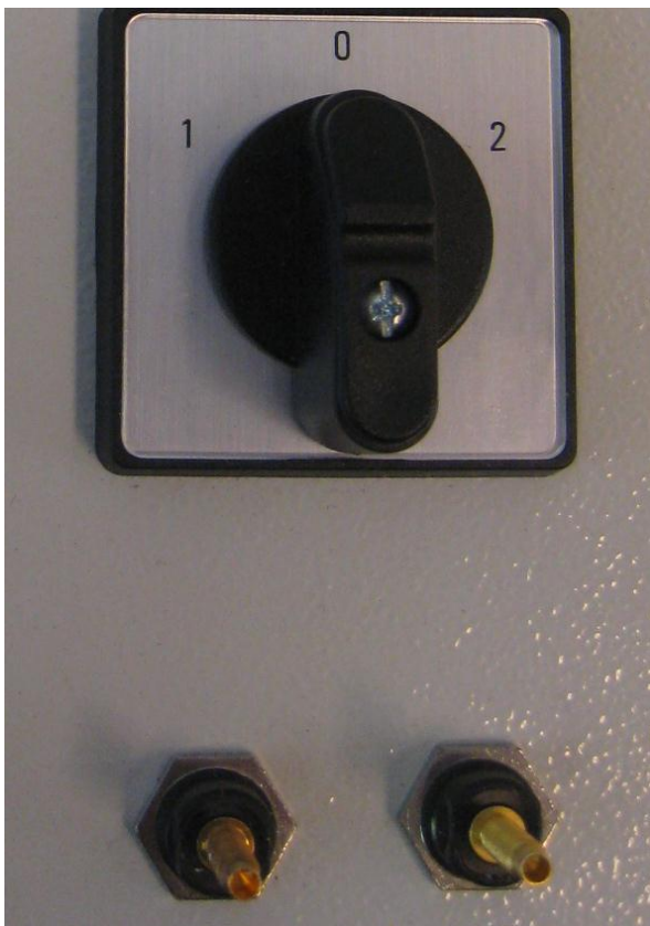
Kuva 8. Eristysresistanssin mittauspiste
