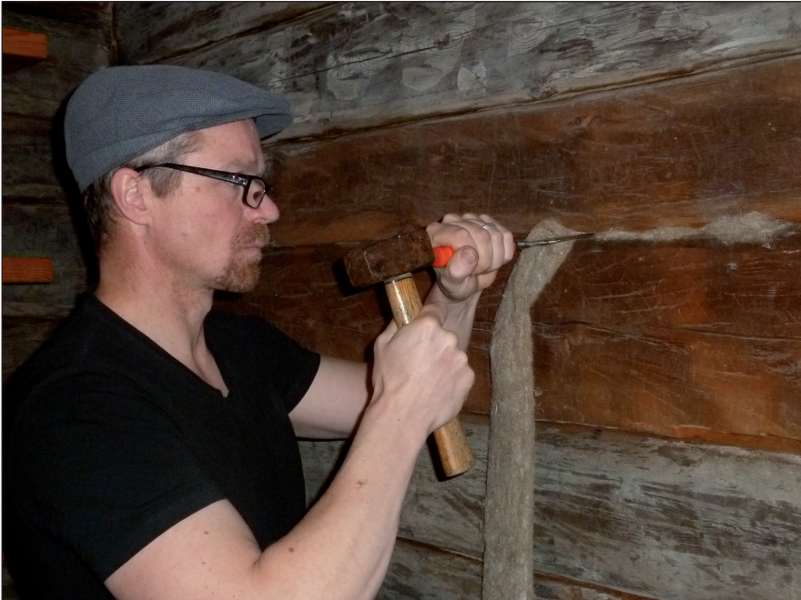
Kuvio 1. Jälkitilkinnällä voidaan parantaa vanhojen hirsiseinien ilmatiiviyttä
