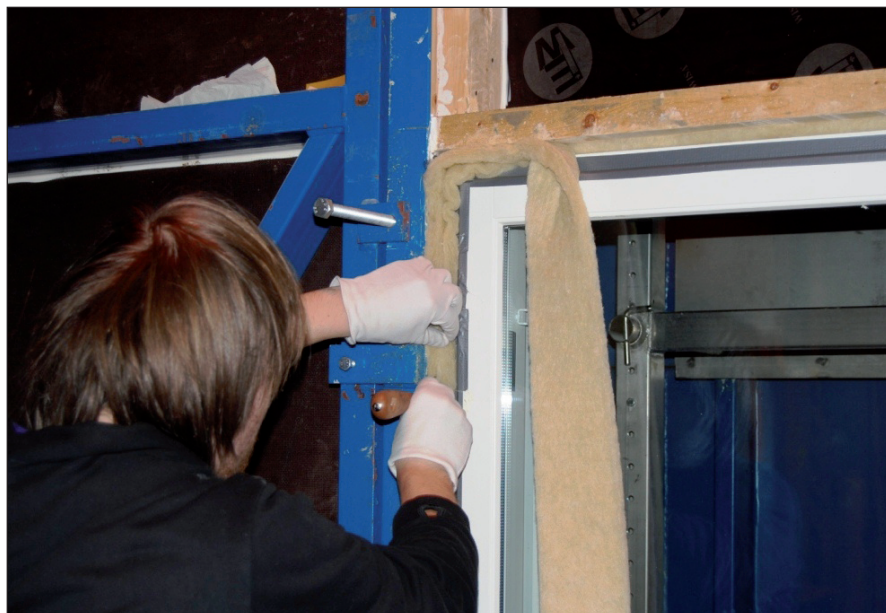
Kuvio 5. Tilkkeen sullontaa kaksinkertaisella tekniikalla
