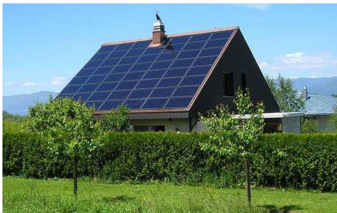
Kuva 6. Omakotitalon paneloitu katto ( isolarpanel.webnode.com )
