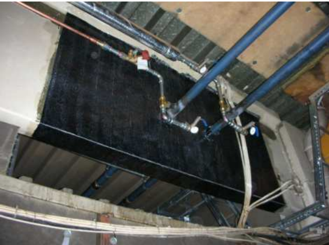
Kuva 6. Palkki vahvistuksen jälkeen (Täljsten ym. 2011, 64)
