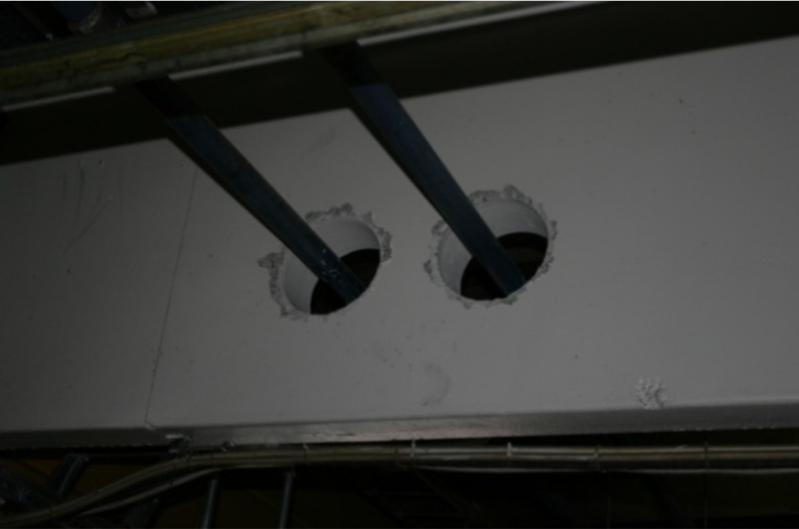
Kuva 5. Palkki ennen vahvistusta (Täljsten ym. 2011, 64)
