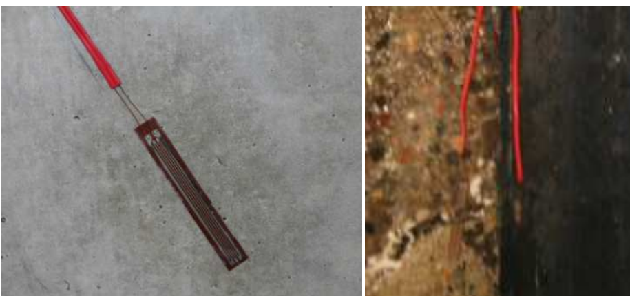
Venymäliuskat betonin pinnassa. Kuva Ville Kantola 2011
