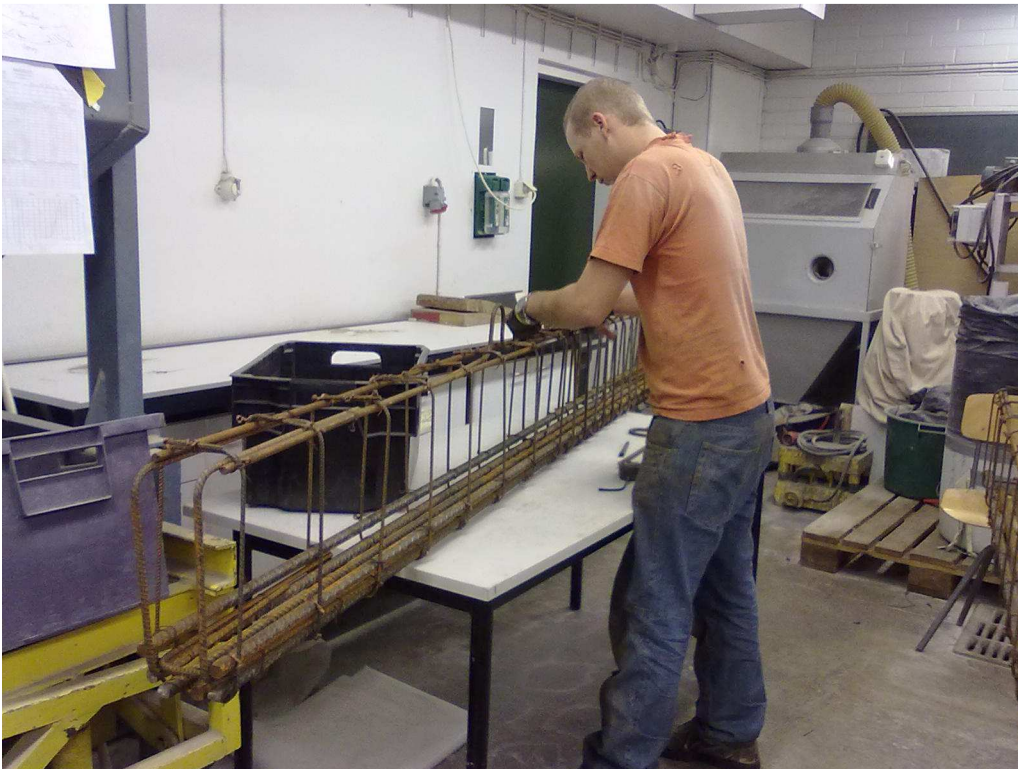
Raudoitushäkkien valmistus. Kuva Henna Intke 2011
