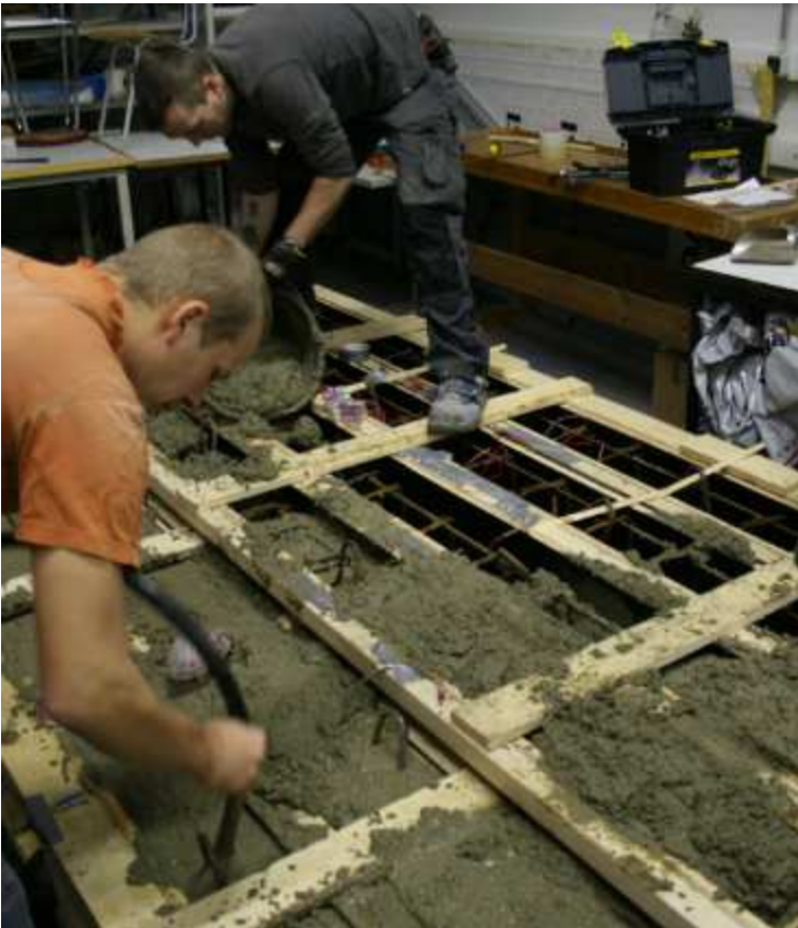
Palkkien valu. Kuva Eemeli Lehmusoksa 2011
