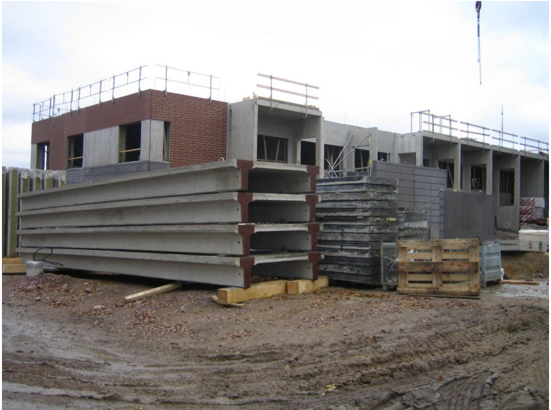
Kuva 3. TT-laatat odottamassa asennusta. Kuva SORTIM Oy
