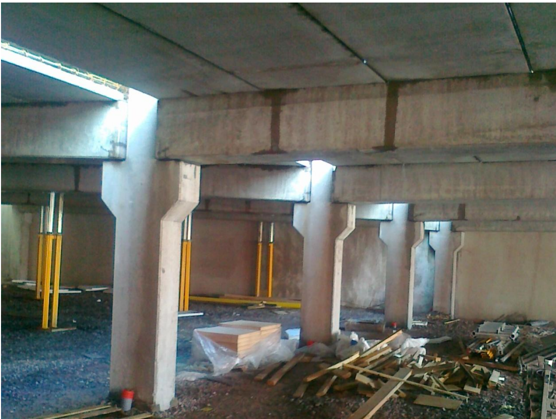
Kuva 2. Leukapilareilla kannatettu palkisto ja laatasto. Kuva SORTIM Oy
