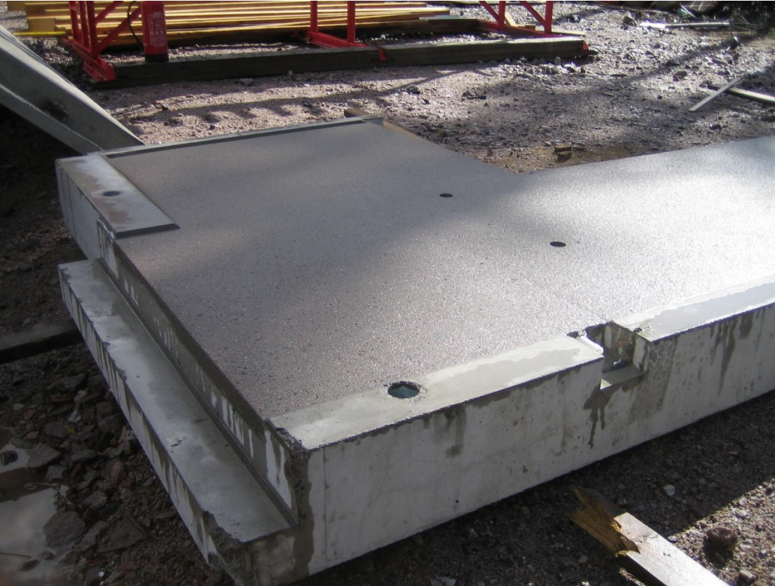
Kuva 4. Massiivielementtilaatta odottamassa asennusta. Kuva SORTIM Oy
