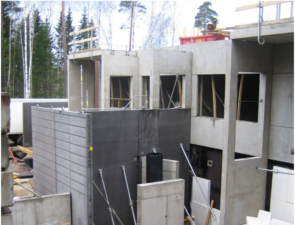
Kuva 1. Elementtirakenteisen asuinkerrostalon pystytysvaihe. Kuva SORTIM Oy
