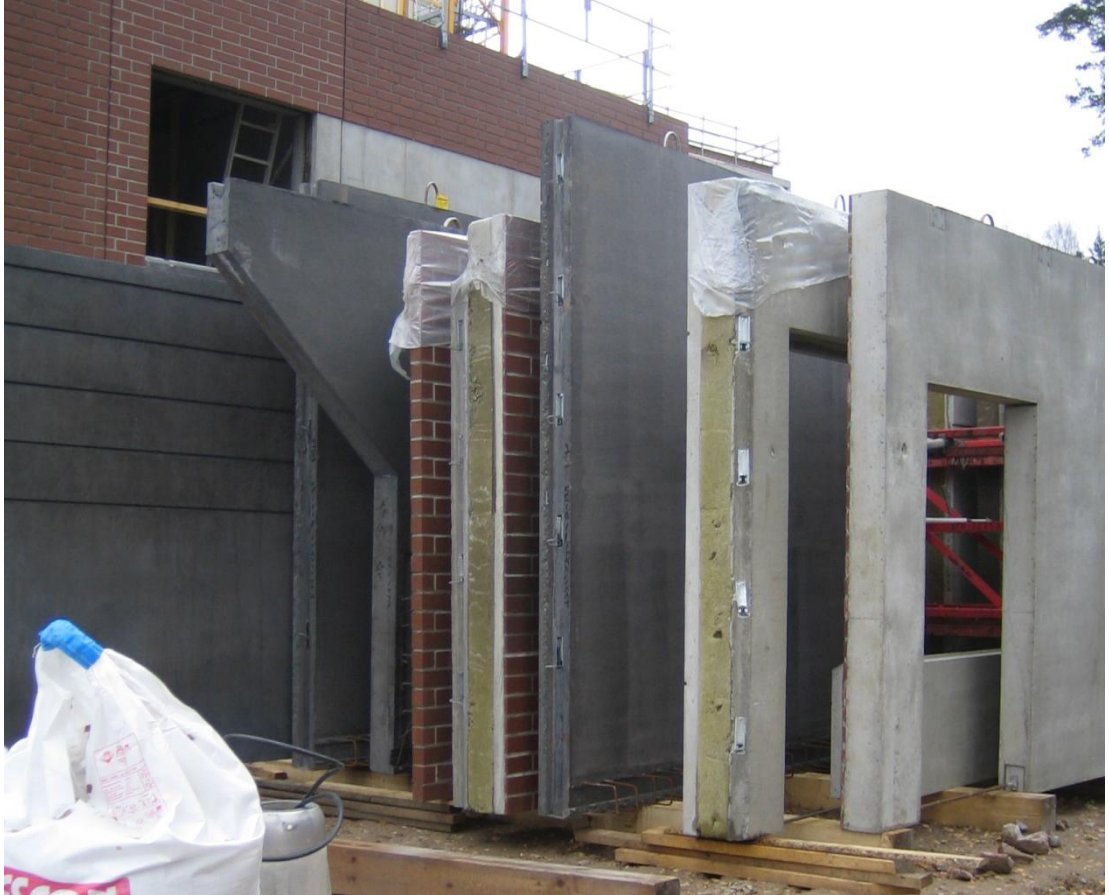
Kuva 5. Seinäelementtejä odottamassa asennusta. Kuva SORTIM Oy
