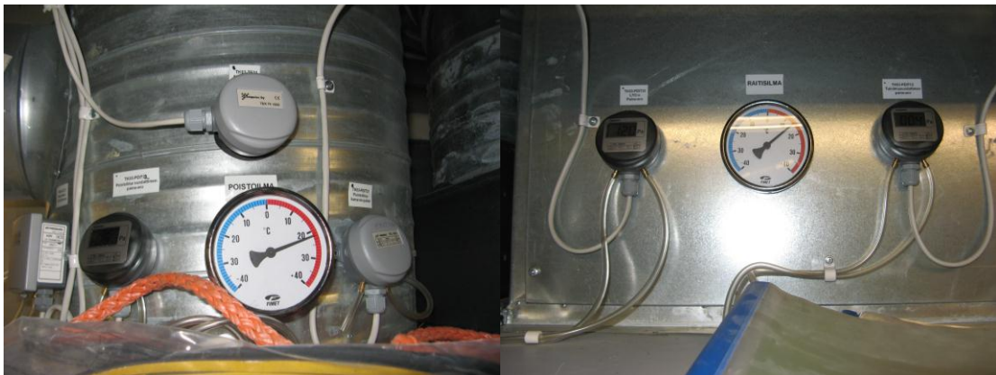
Kuva 7. Ilmastoinnin mittausantureita.
