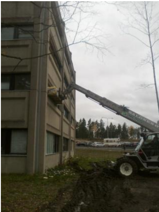
KUVA 4. Kipsilevyjen nosto kerrokseen
