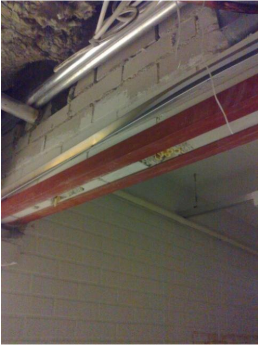
KUVA 5. Puretun aukon tuenta kulmarauhoilla
