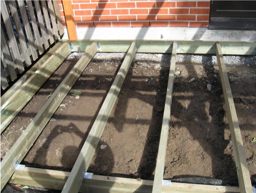
Kuva 8. Poistettu pintamaa ja suodatinkankaan asennus. Kuva Marko Vartiainen
