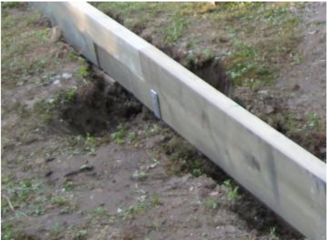
Kuva 7, pilarikengä ja kestopuurunko. Kuva Marko Vartiainen.
