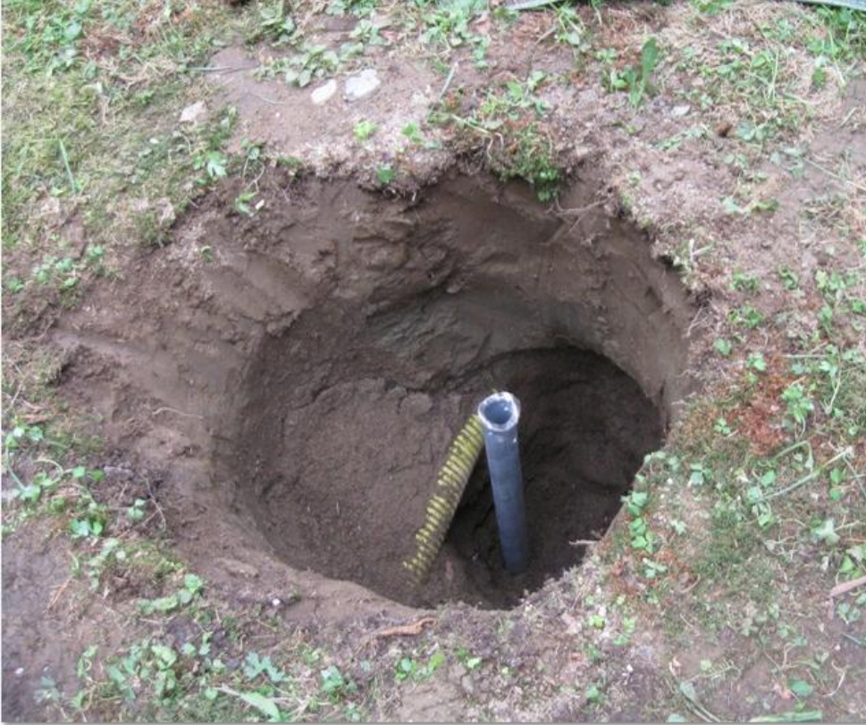
Kuva 5. Teräsputkipaalu, salaoja ja routalaakerin kaivanto.
