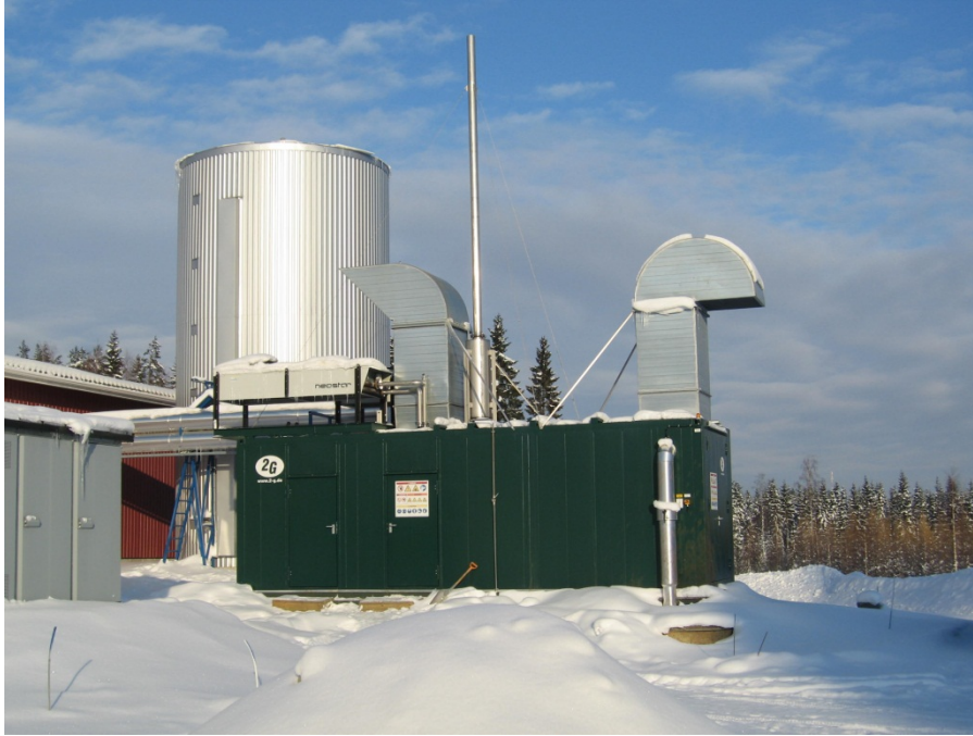
KUVA 7. Juvan Bioson Oy:n biokaasulaitoksen CHP-yksikkö sijaitsee Turakkalan Puutarha Oy:n yhteydessä (kuva Hanne Soininen)
