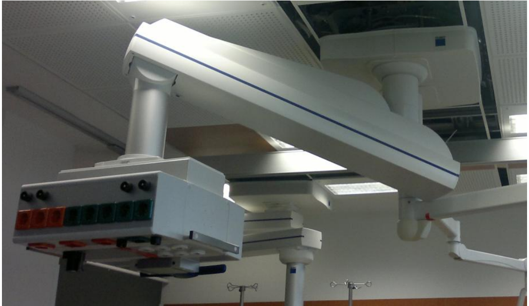
Kuvio 4. Tehohoitopaikan jalkopään kattokeskus.
