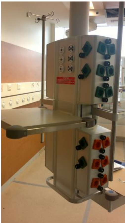
Kuvio 3. Tehohoitopaikan vasemmanpuoleinen kattokeskus.
